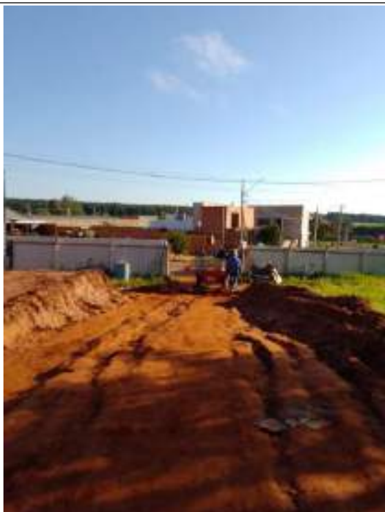
Arranque de pilar
