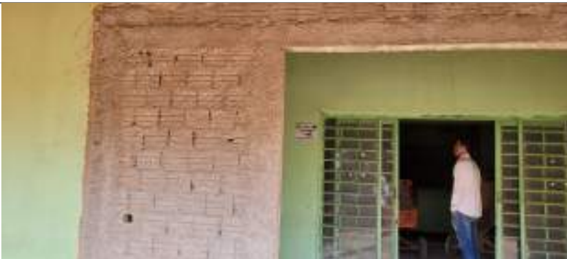
Imagem 9 – Alvenaria, Chapisco e Emboço
