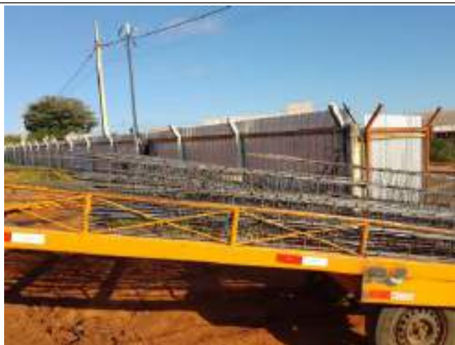
Arranque de pilar
