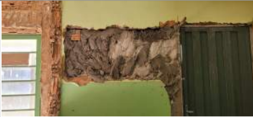
Imagem 11 – Retirada de esquadria metálica
