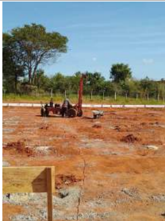
Andamento Estaca Franki com fuste apiolado.
