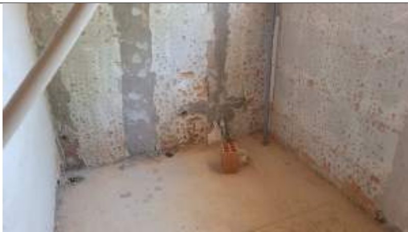
Imagem 04 – Instalação de esgoto
