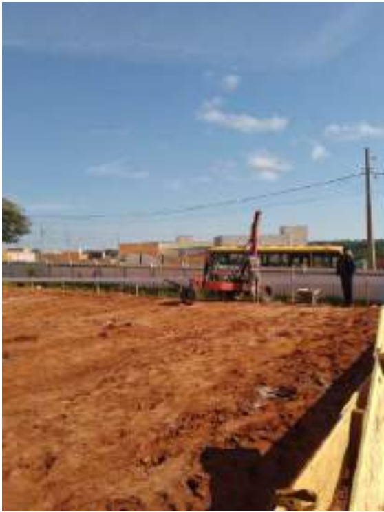
Inicio Estaca Franki com fuste apiolado.
