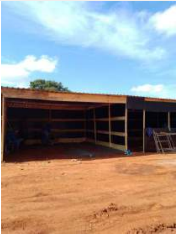
Canteiro de obras
