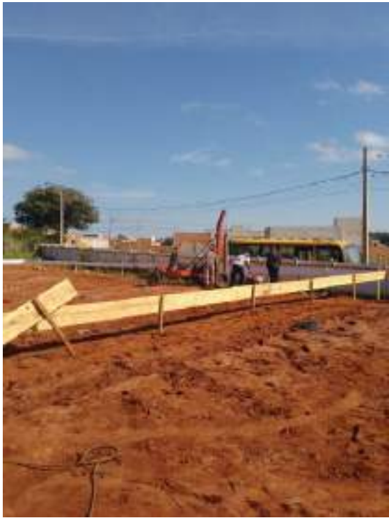
Inicio Estaca Franki com fuste apiolado.
