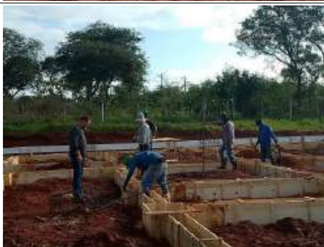
Montagem das armaduras horizontais das vigas baldrame
