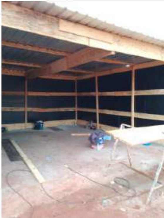
Canteiro de obras
