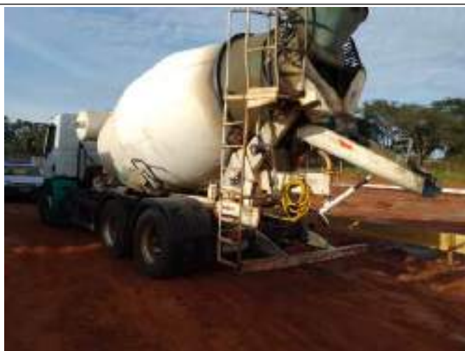
Descarregamento de concreto
