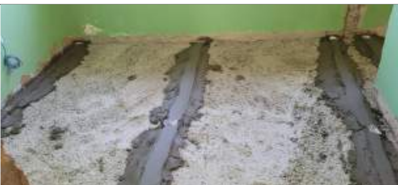
Imagem 10 – Concreto para nivelamento do piso
