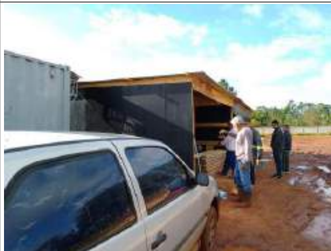
Canteiro de obras
