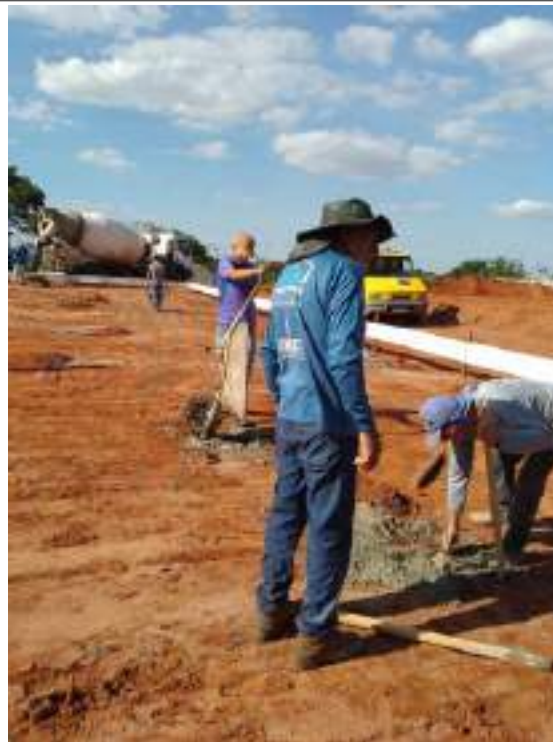
Enchimento das estacas
