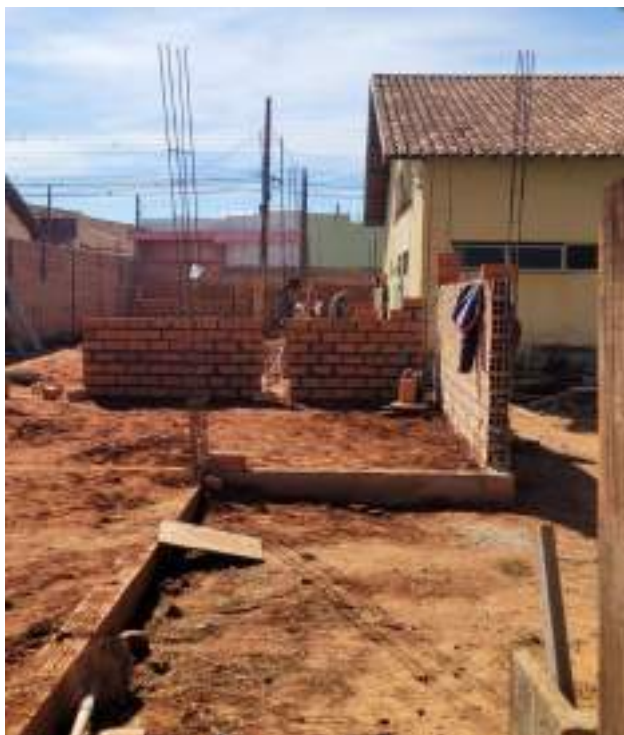
Imagem 03 – Baldrame, ferragem dos pilares e alvenaria
