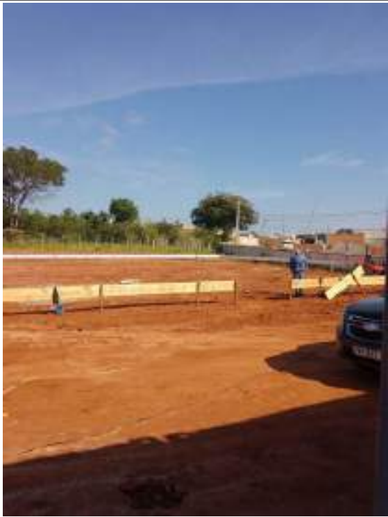
Inicio Estaca Franki com fuste apiolado.
