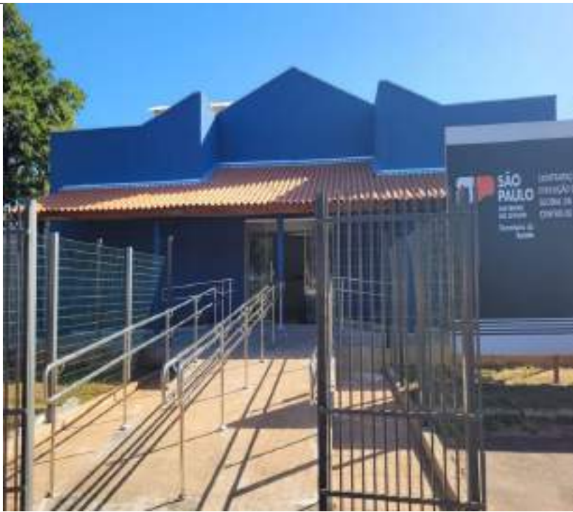
Imagem 05 – Pintura, gradil, portão, corrimão
