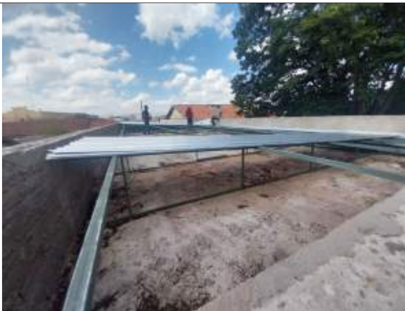
Imagem 09 – Estrutura metálica do telhado
