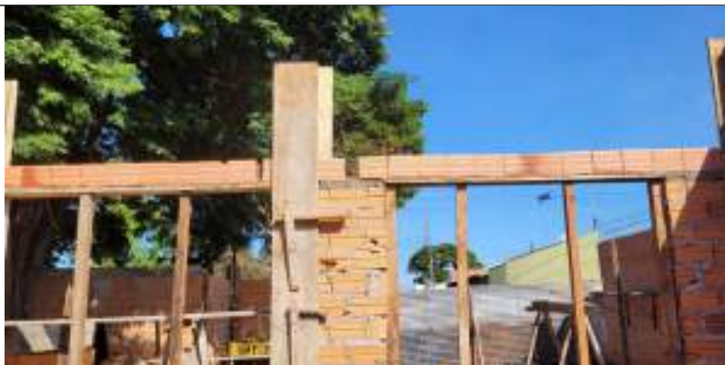
Imagem 05 – Canaleta para verga
