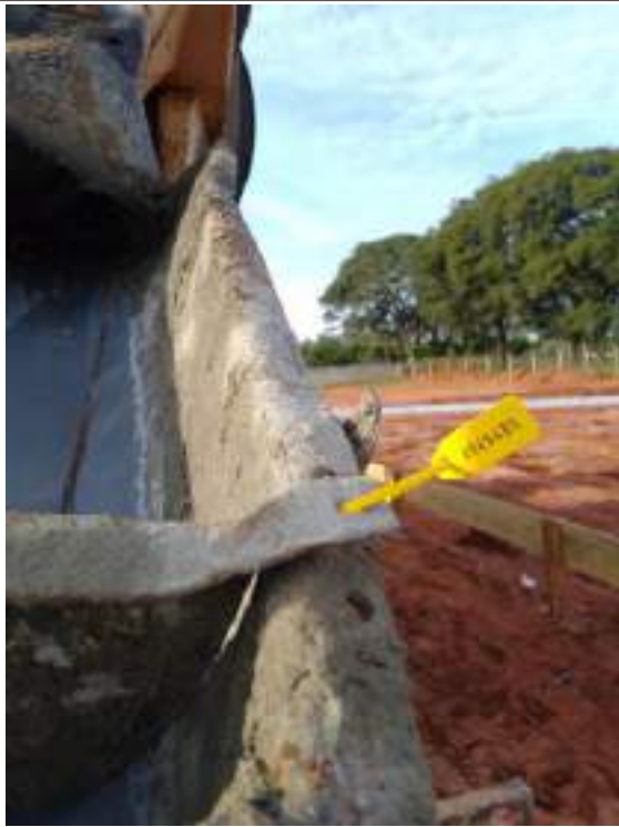
Lacre do caminhão de concreto
