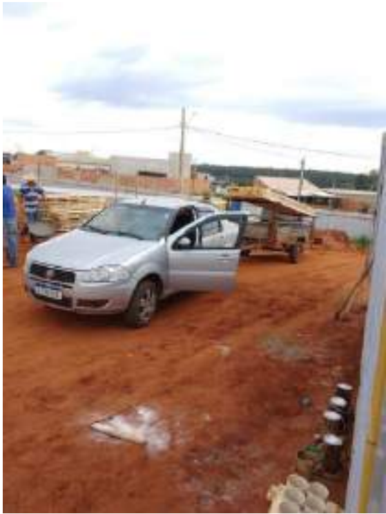
Chegada dos somente dos sarrafos
