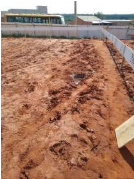
Inicio Estaca Franki com fuste apiolado.
