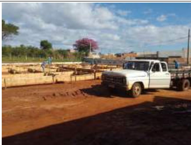
Chegada dos 200 sarrafos de 5 para travar as caixas
