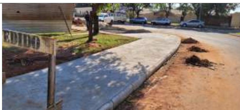
Imagem 03 – Calçada e guia
