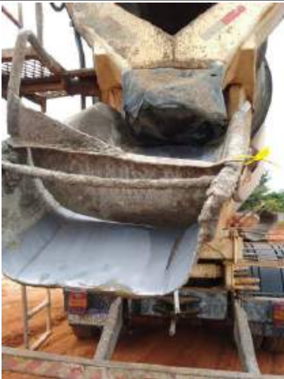
Lacre do caminhão de concreto- a tarde
