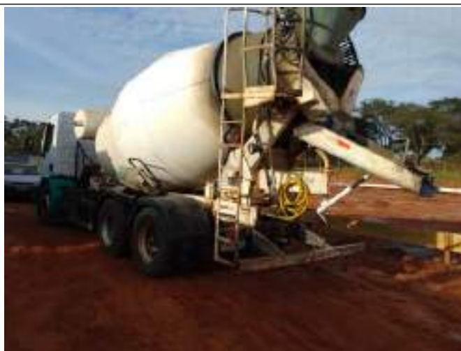
Caminhão de concreto
