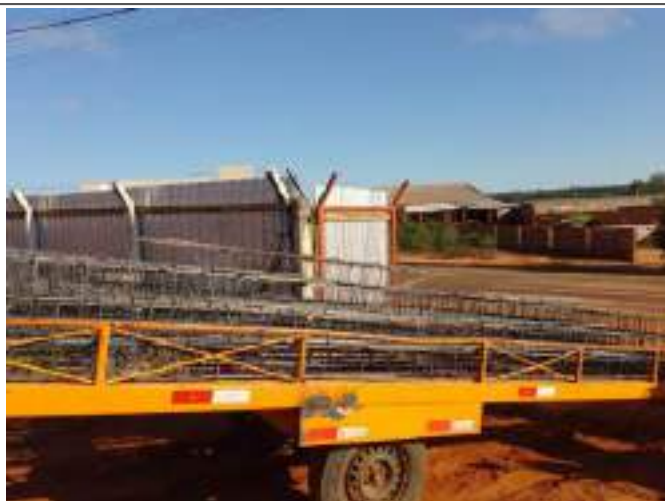
Arranque de pilar
