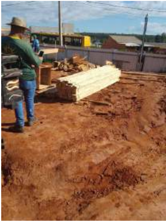
200 sarrafos de 5 para travar as caixas
