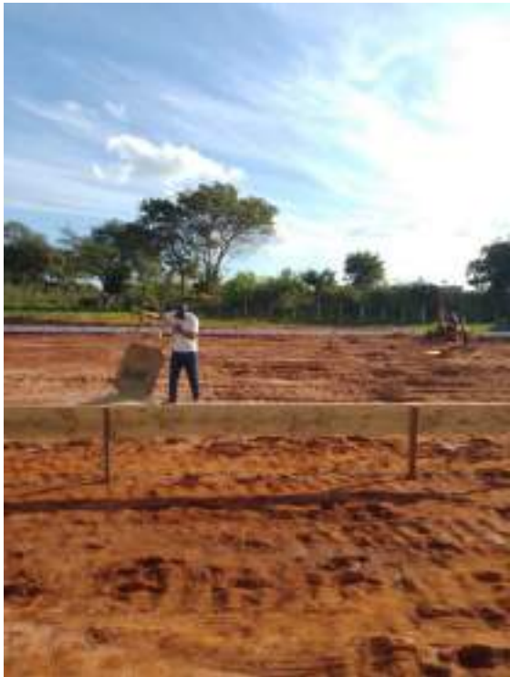
Início Estaca Franki com fuste apoiado.
