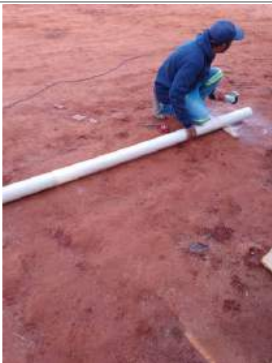
Corte do pvc para corpo de prova
