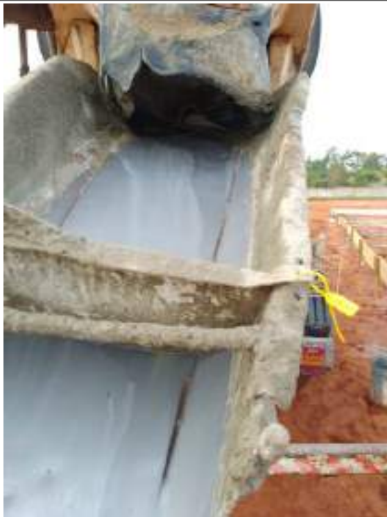
Lacre do caminhão de concreto
