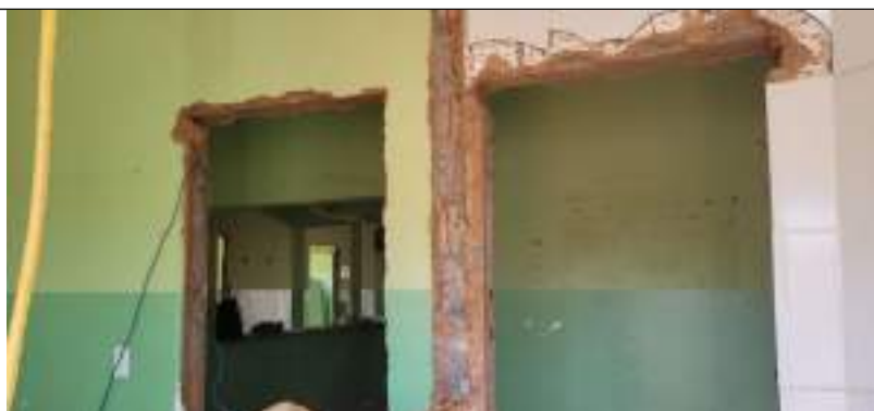
Imagem 03 – Retirada de portas e batentes
