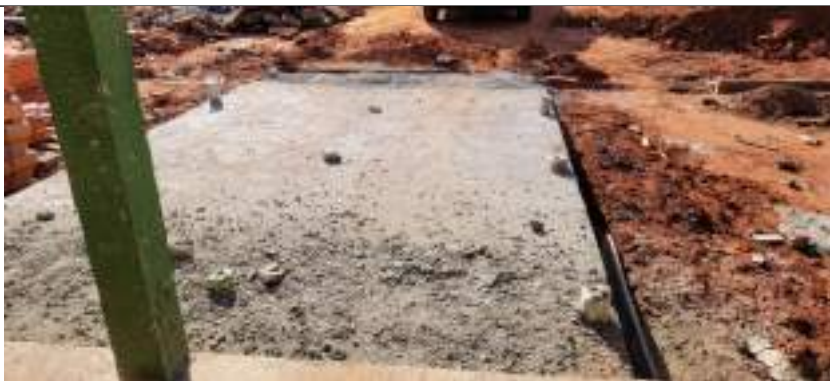
Imagem 11 – Rampa de acessibilidade
