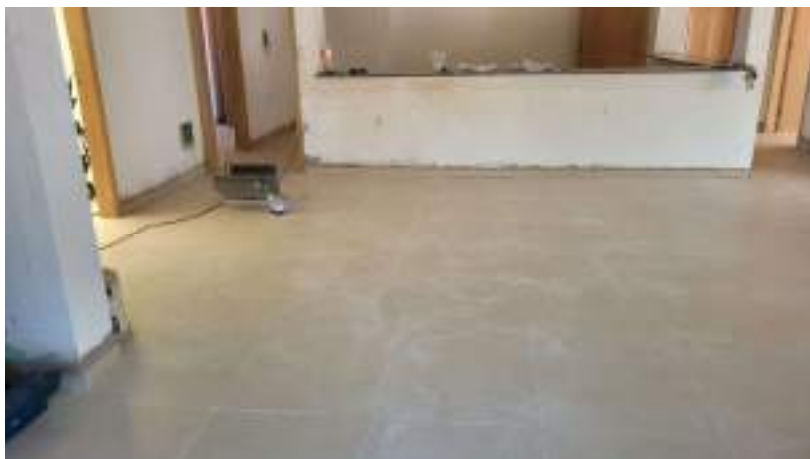
Imagem 02 – Piso e rodapé
