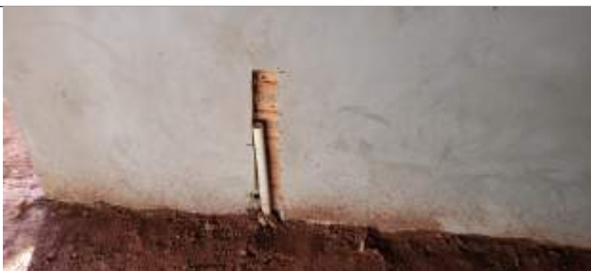
Imagem 04 – Tubo PVC para esgoto
