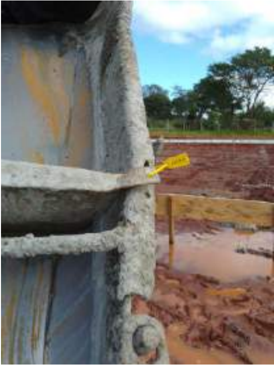
Lacre do caminhão de concreto
