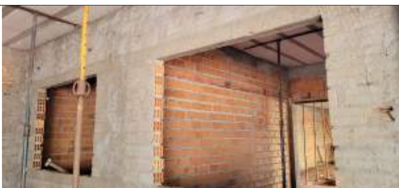
Imagem 06 – Alvenaria e chapisco
