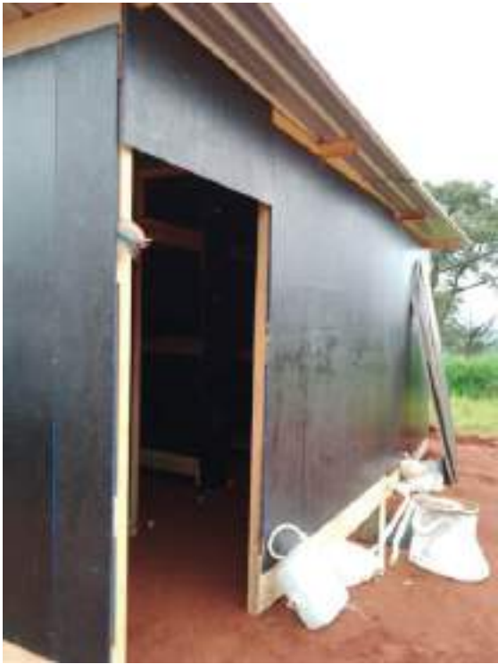
Canteiro de obras
