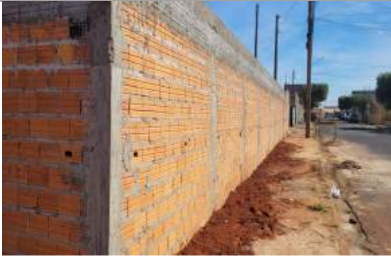
Imagem 11 – Construção do muro
