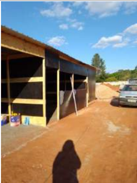
Canteiro de obras
