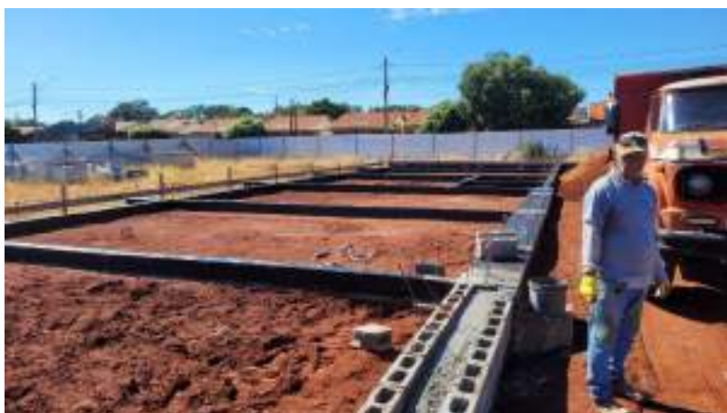
imagem 08 – Bloco de embasamento e impermeabilizante
