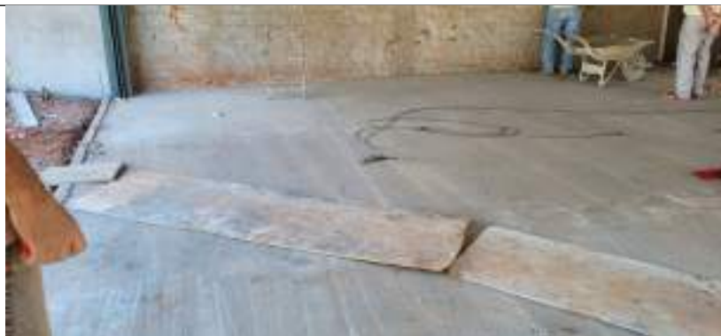
Imagem 10 – Contrapiso, chapisco e reboco
