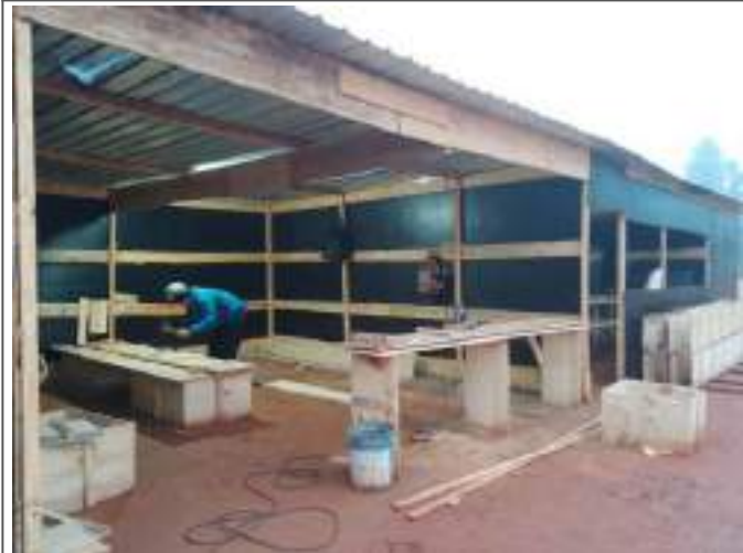
Desenvolvimento das formas para as vigas
