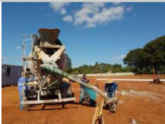
Descarregamento de Concreto
