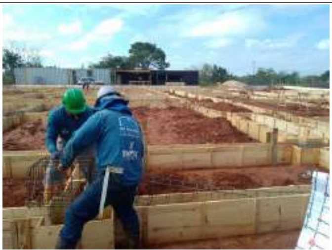
Montagem das armaduras horizontais das vigas baldrame
