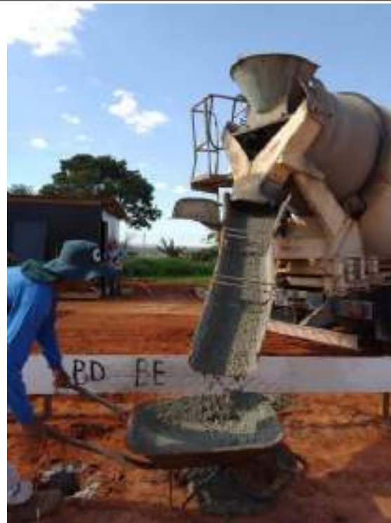
Descarregamento do concreto
