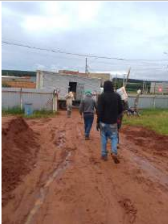
Descarregamento das 18 unidades de impermeabilizante
