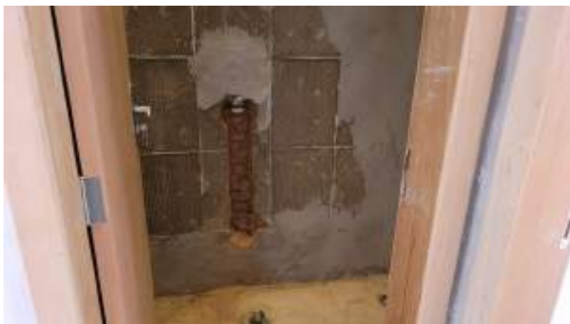
magem 8 – Instalação de água fria
