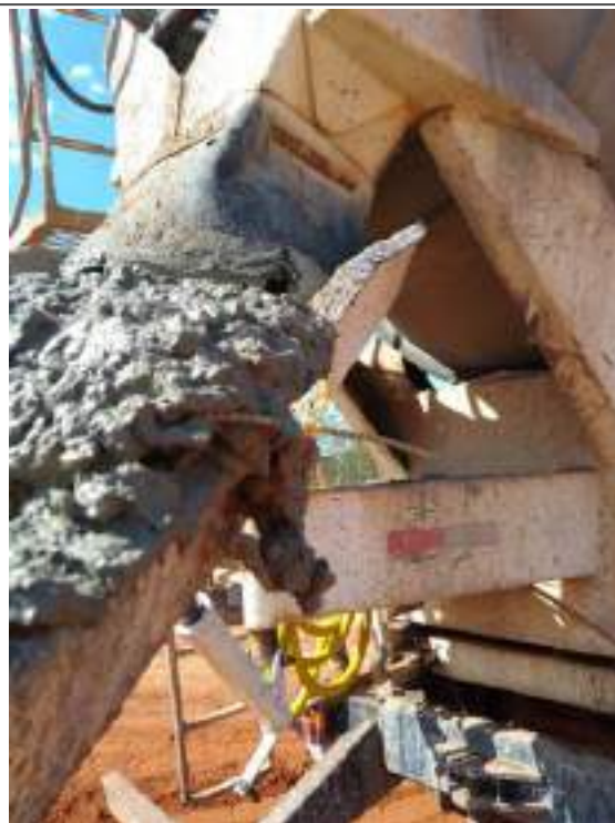
Lacre do caminhão de concreto
