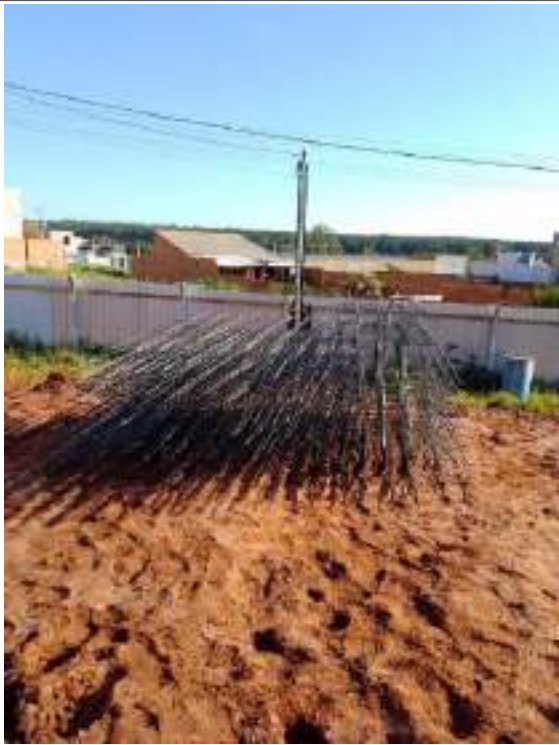
Arranque de pilar
