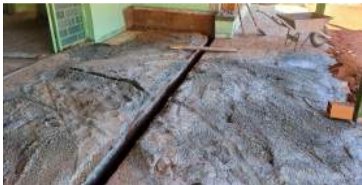
Imagem 06 – Concreto para nivelamento de piso
