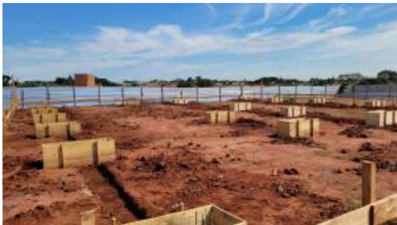
magem 05 – Caixaria para blocos
