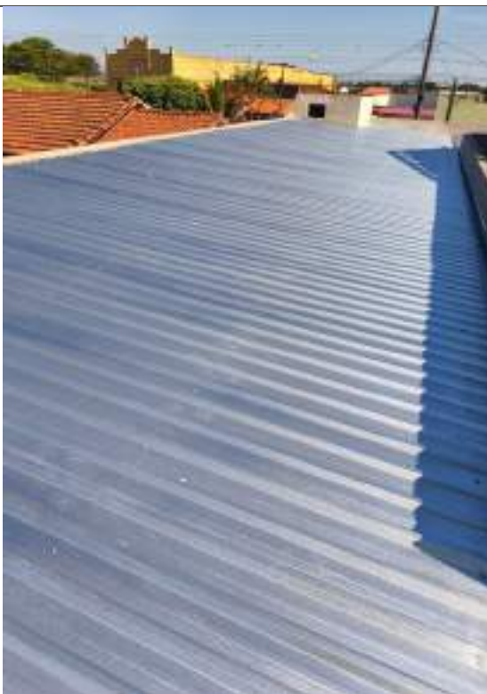
Imagem 05 – Telha metálica
