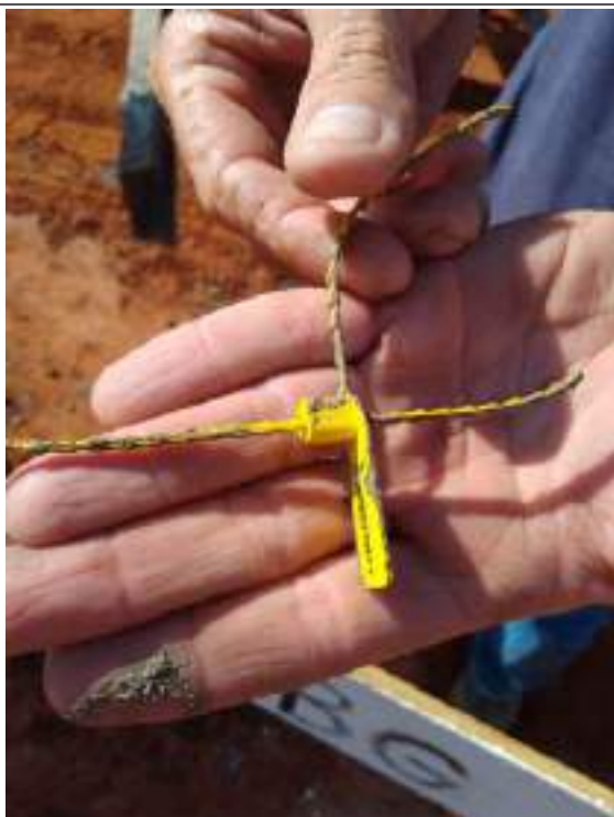
Lacre do caminhão de concreto
