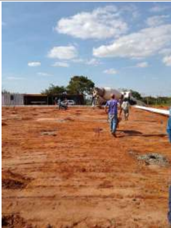
Enchimento das estacas
