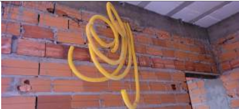
Imagem 07 – Alvenaria e tubo flexível
