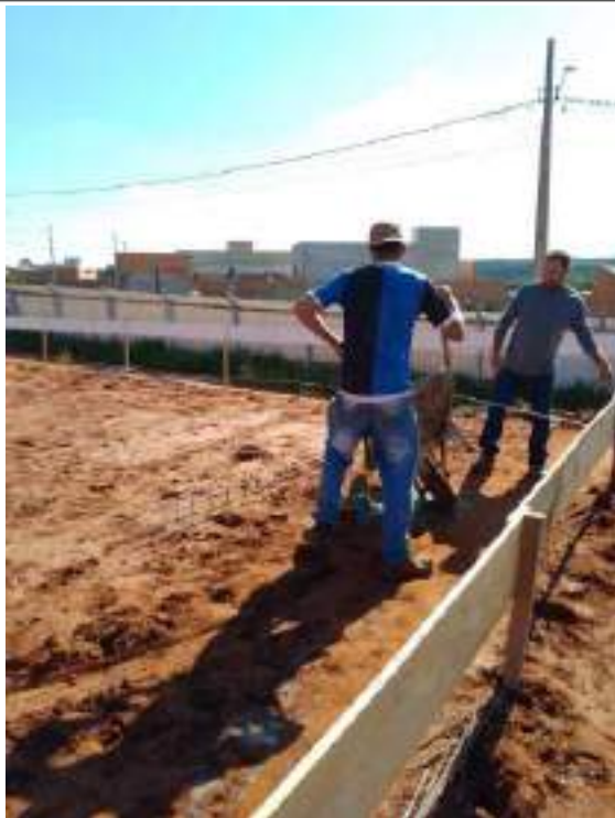
Enchimento das estacas
