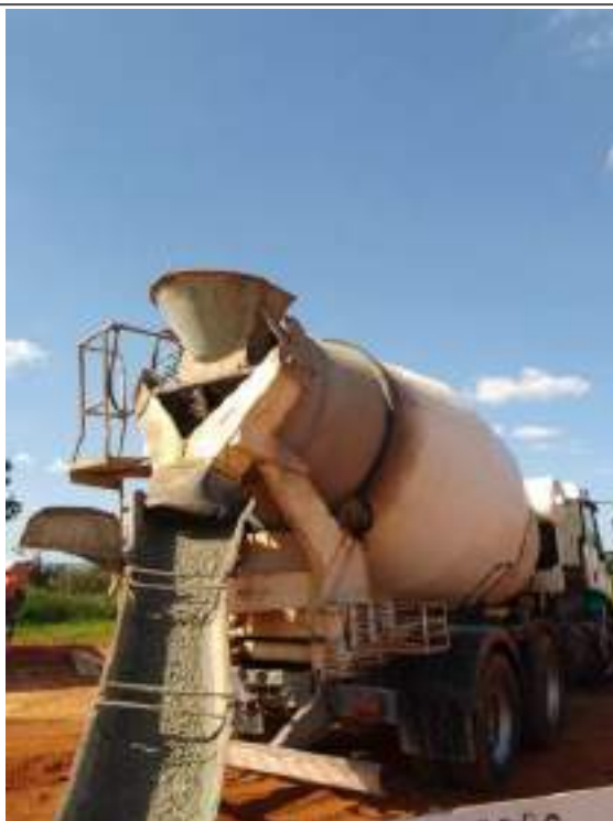
Caminhão de concreto
