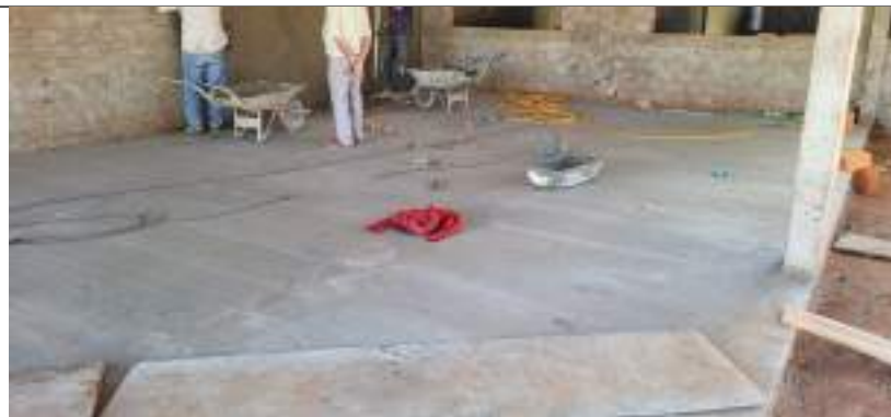
Imagem 09 – Contrapiso, chapisco e reboco
