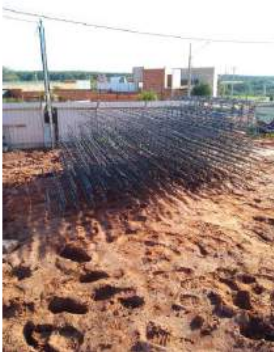
Arranque de pilar
