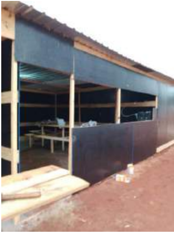
Canteiro de obras
