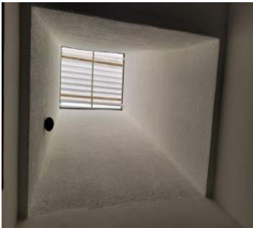
Imagem 12 – Pintura e telhado
