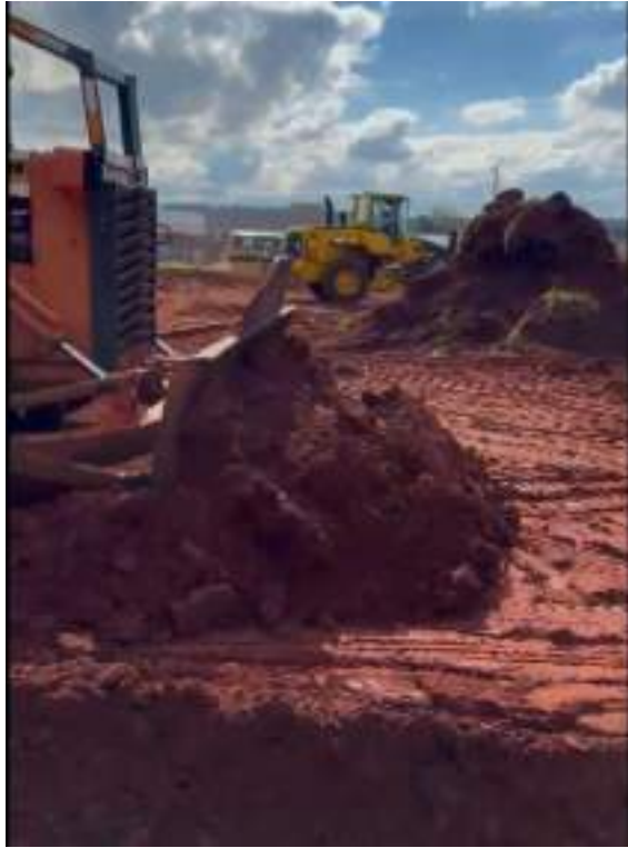
2 Maquinas e Dois CAminhões de Bota Fora
