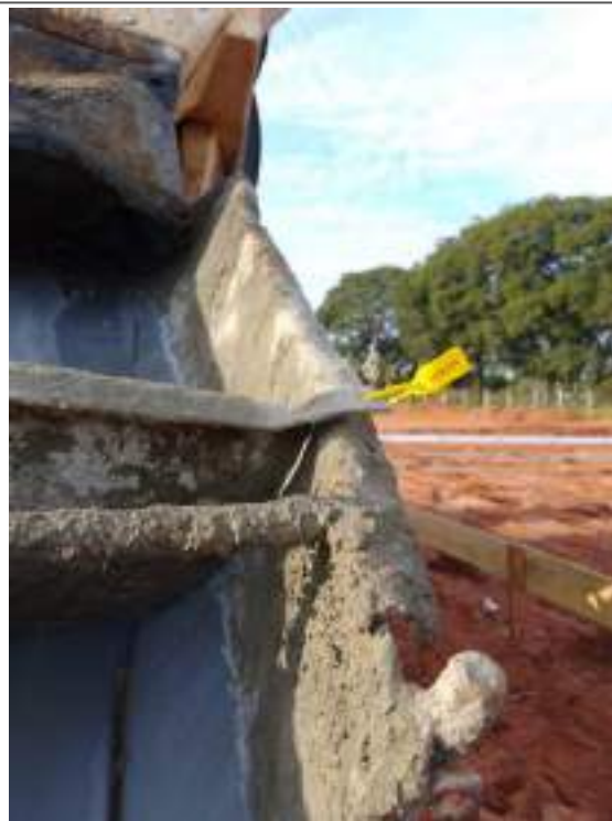
Lacre do caminhão de concreto
