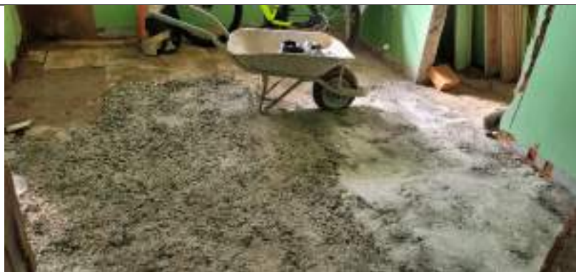
Imagem 04 – Concreto para nivelamento do piso
