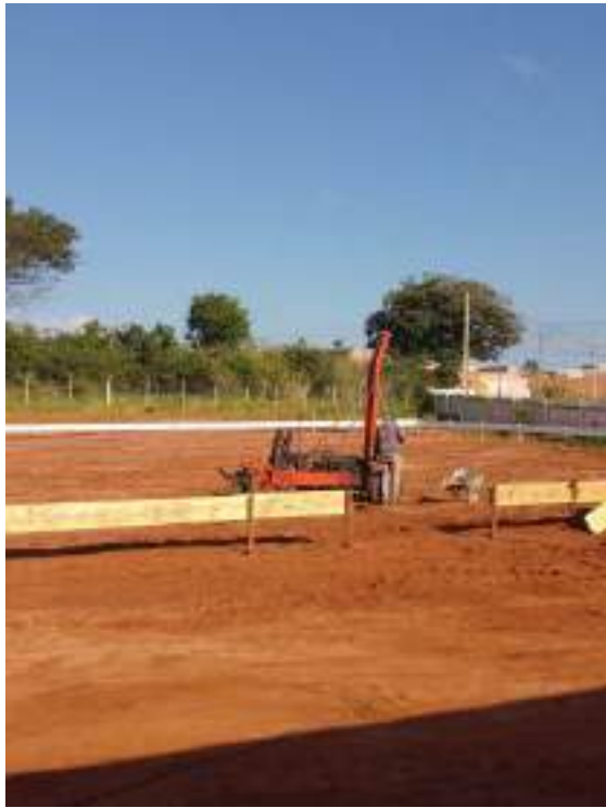
Inicio Estaca Franki com fuste apiolado.
