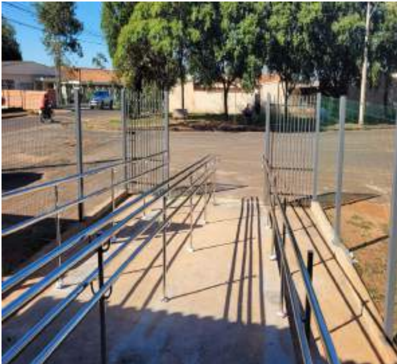
Imagem 06 – Gradil, portão, corrimão
