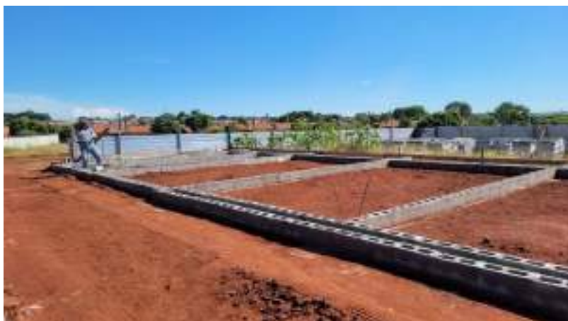
imagem 07 – Bloco de embasamento e impermeabilizante
