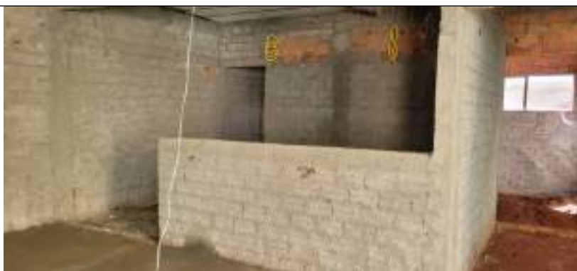
Imagem 06 – Tubo PVC flexível e chapisco
