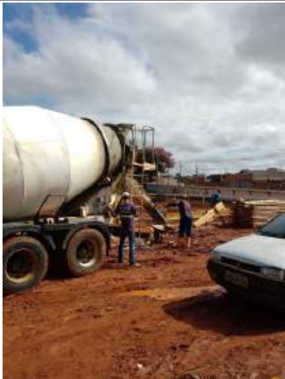
Caminhão de concreto
