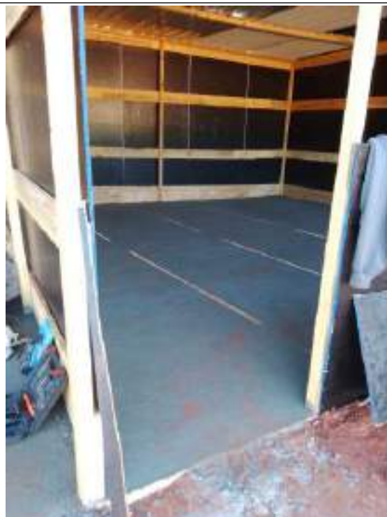
Canteiro de obras
