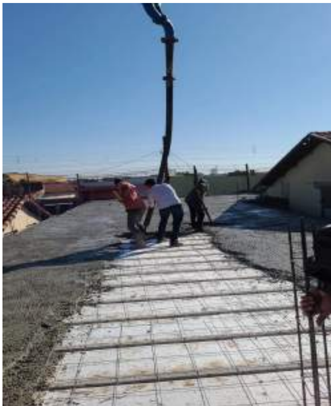
Imagem 01 – Concretagem da laje
