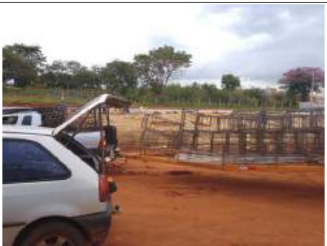
Chegada das armaduras das vigas
