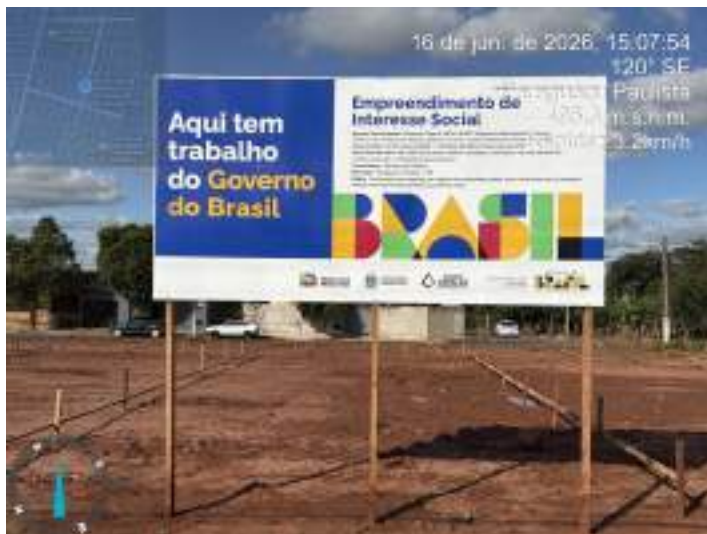
FORNECIMENTO E INSTALAÇÃO DE PLACA DE OBRA COM CHAPA GALVANIZADA E ESTRUTURA DE MADEIRA. AF 03/2022 PS
