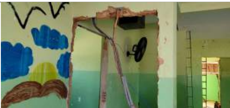
Imagem 05 – Demolição de alvenaria
