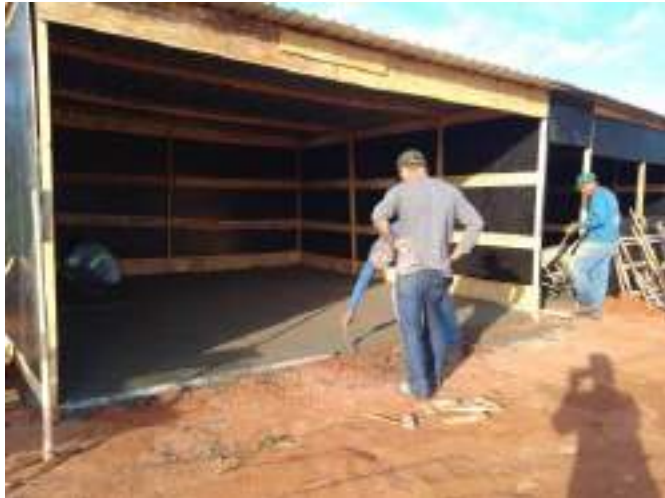
Canteiro de obras
