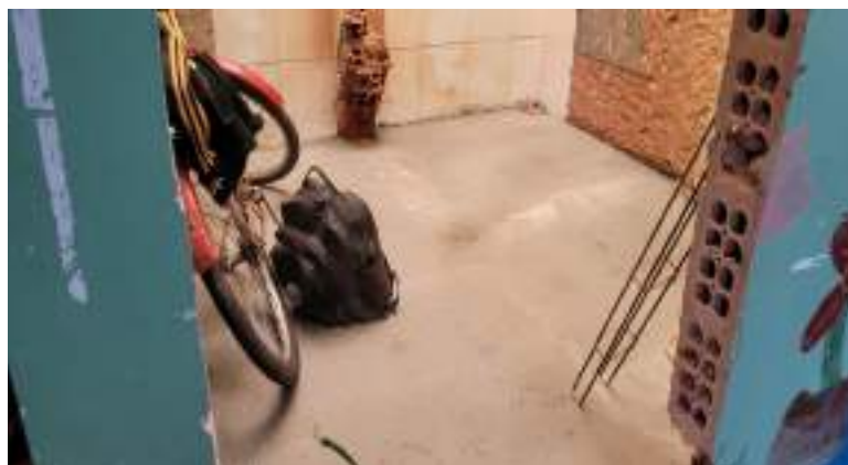
Imagem 03 – Contrapiso e nivelamento
