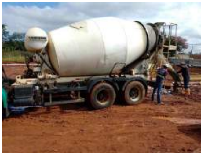
Caminhão de concreto
