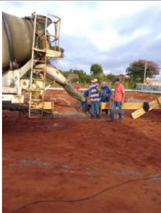
Descarregamento de concreto
