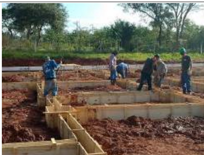
Montagem das armaduras horizontais das vigas baldrame
