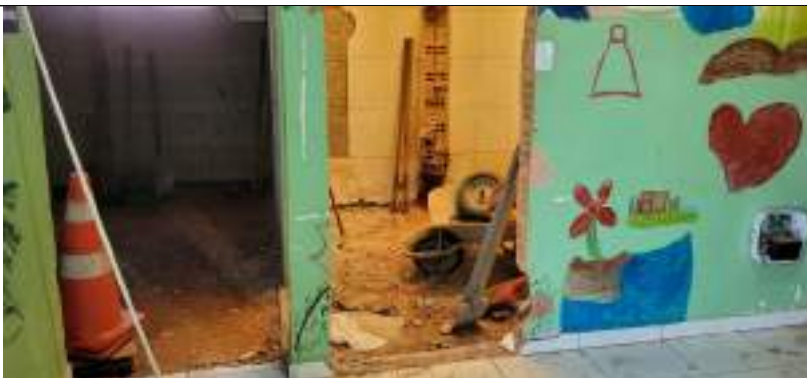
Imagem 07 – Demolição de alvenaria
