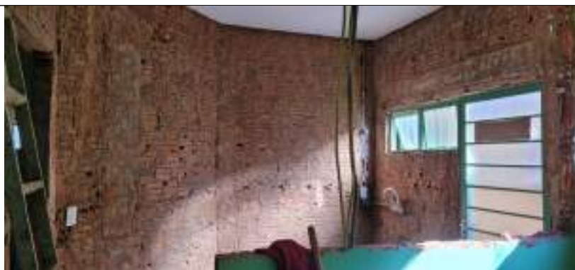
Imagem 08 – Demolição de revestimento cerâmico
