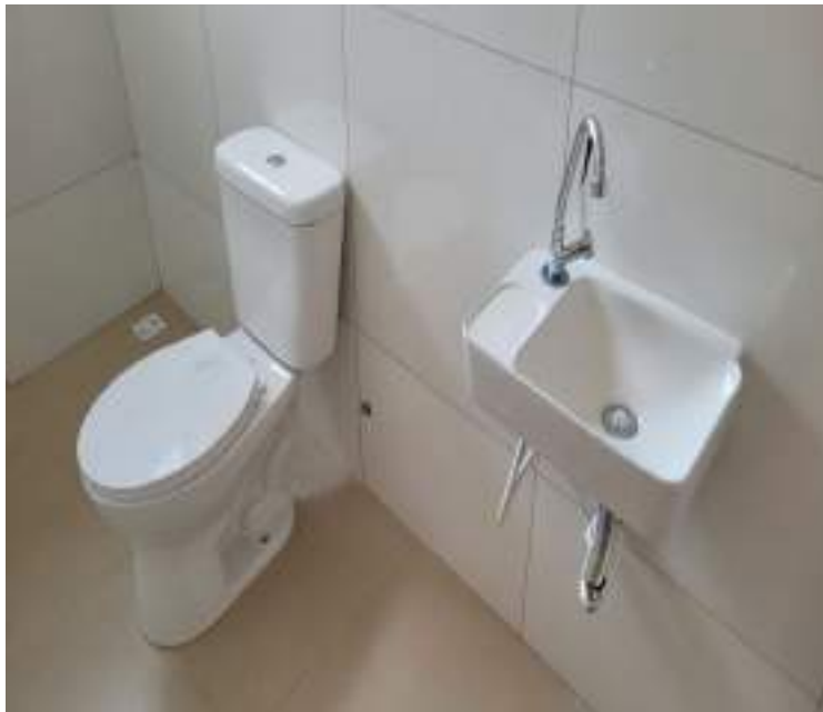
Imagem 04 – Revestimento, bacia sanitária e cuba
