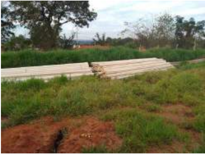
Realocação dos canos atrás dos containers/alojamento. Serão cobertos com a lona
