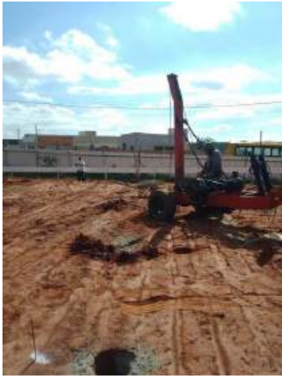
Inicio Estaca Franki com fuste apiolado.
