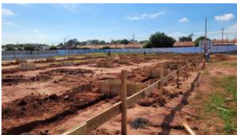
magem 06 – Gabarito, caixaria para blocos e abertura de vala para baldrame
