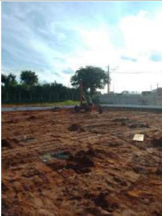
Início Estaca Franki com fuste apoiado.
