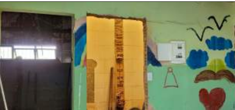
Imagem 06 – Demolição de alvenaria
