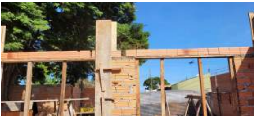
Imagem 03 – Verga e contraverga em cerâmica
