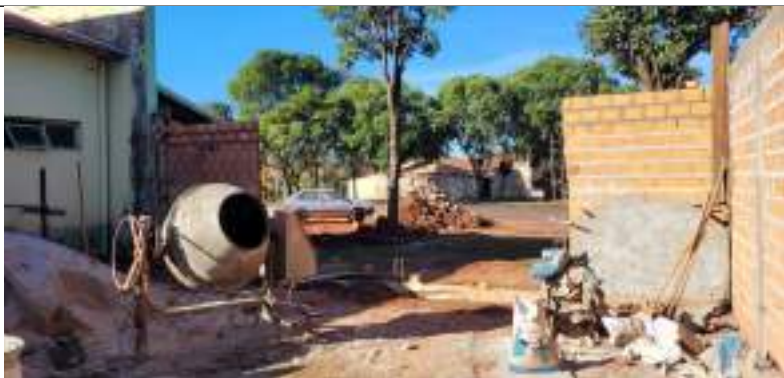
Imagem 01 – Construção do muro
