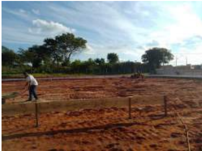
Início Estaca Franki com fuste apoiado.
