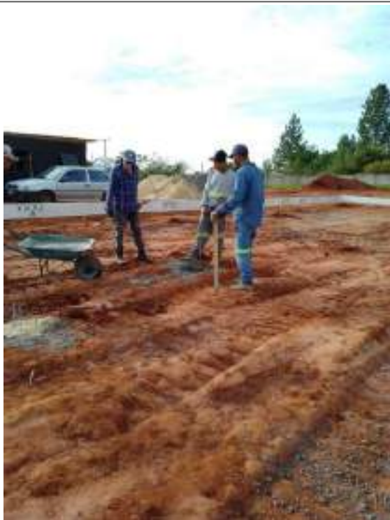
Enchimento das estacas
