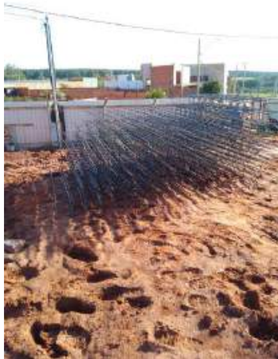
Arranque de pilar
