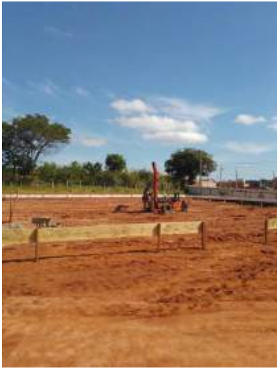
Inicio Estaca Franki com fuste apiolado.
