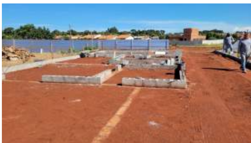
Imagem 06 – Bloco de embasamento
