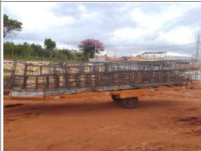
Chegada das armaduras das vigas
