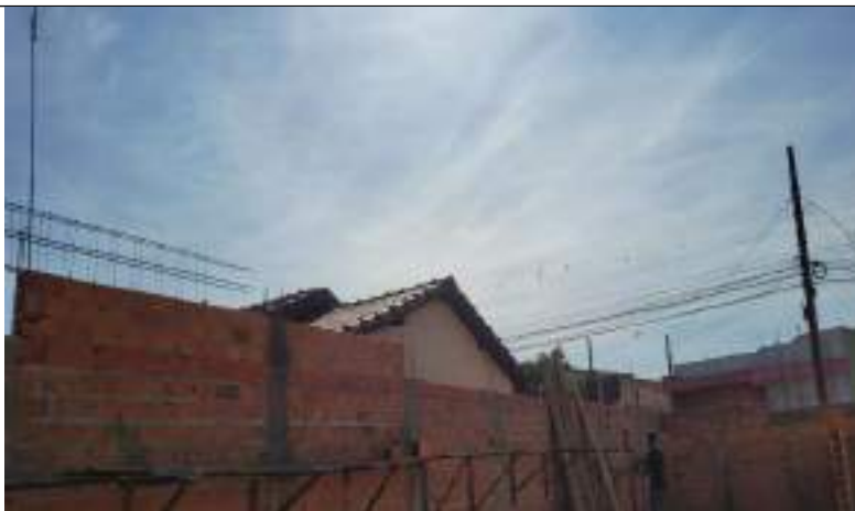
Imagem 13 – Muro de divisa e ferragens
