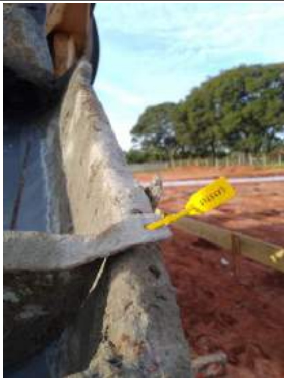
Lacre do caminhão de concreto
