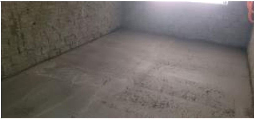
Imagem 08 – Contrapiso e chapisco
