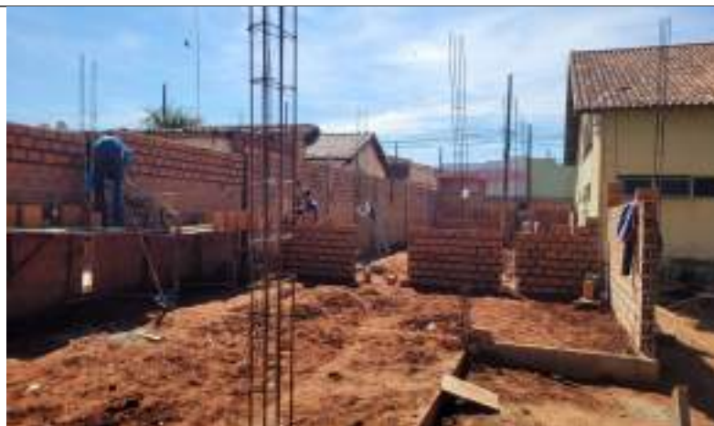
Imagem 04 – Baldrame, ferragem dos pilares e alvenaria
