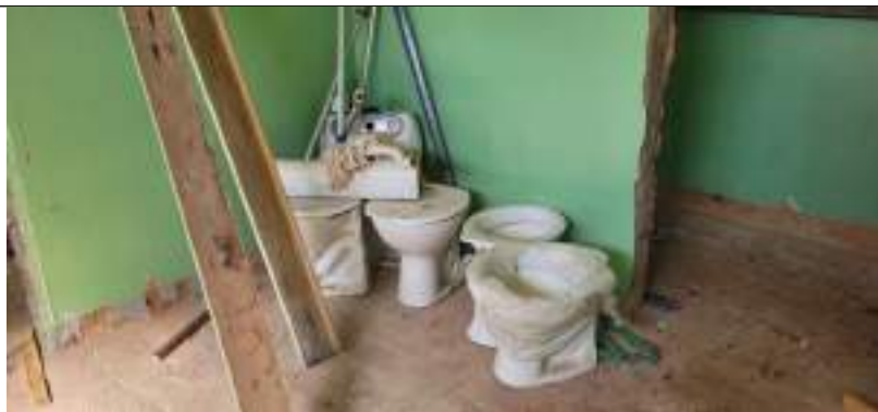
Imagem 08 – Retirada de aparelho sanitário
