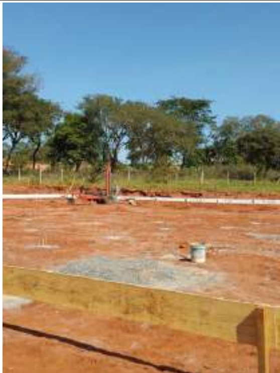
Andamento Estaca Franki com fuste apiolado.
