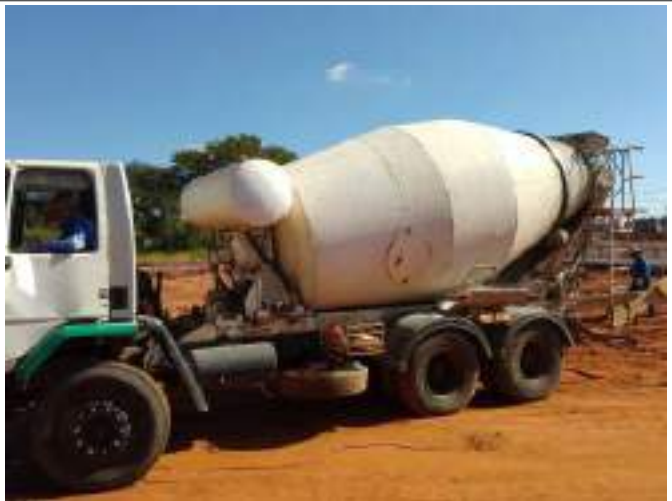
Caminhão de concreto
