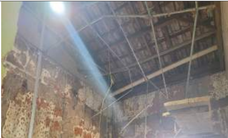
Imagem 12 – Retirada de ferro
