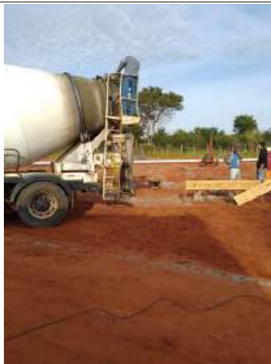
Descarregamento de concreto
