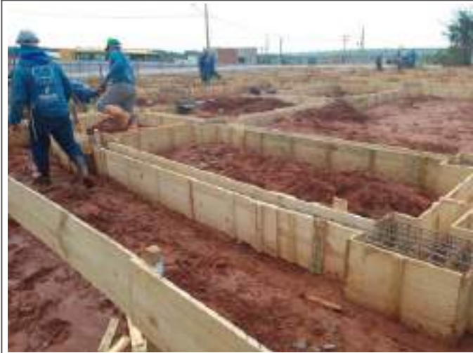
Montagem das armaduras horizontais das vigas baldrame
