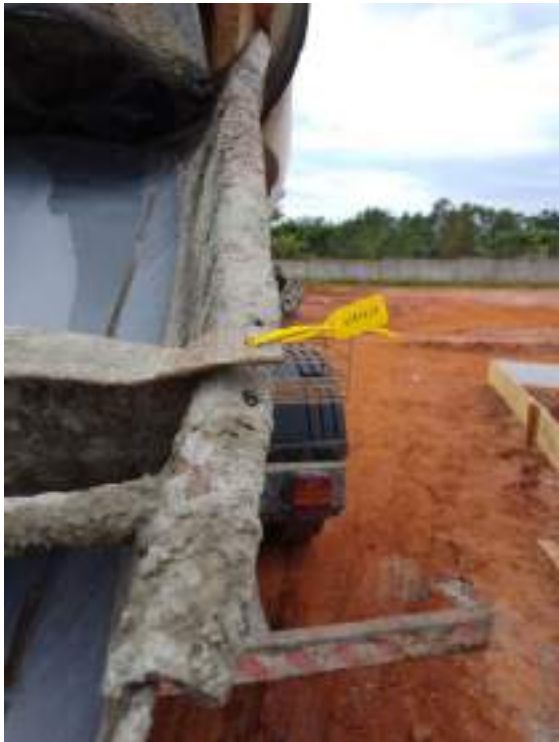
Lacre do caminhão de concreto- a tarde
