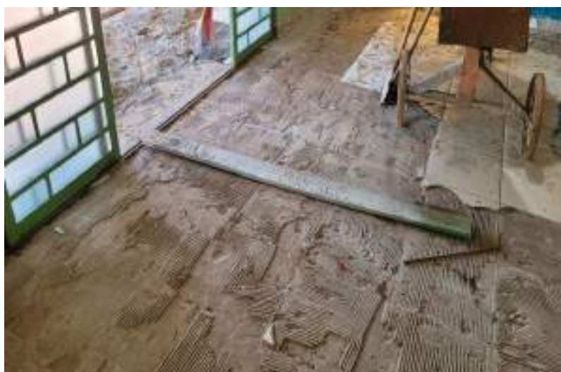
Imagem 02 – Retirada de pisos
