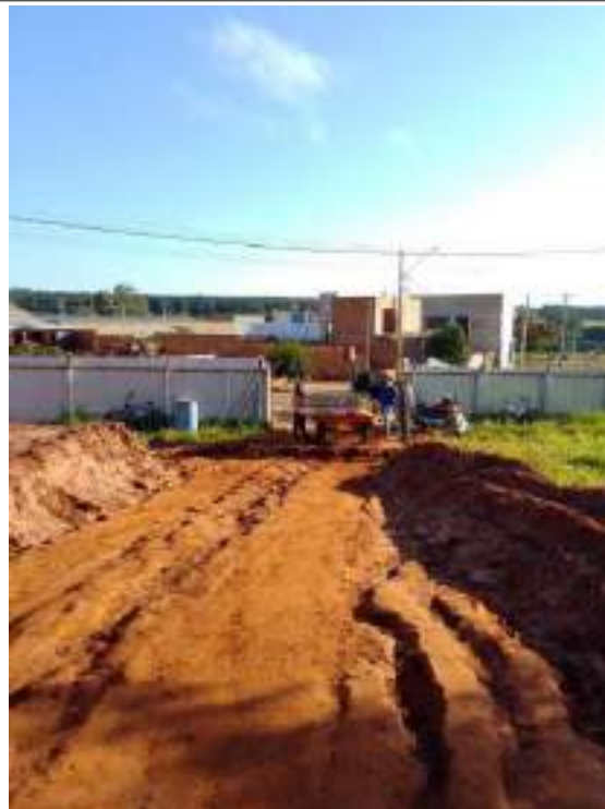
Arranque de pilar
