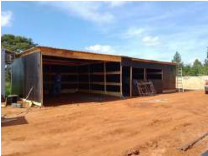
Canteiro de obras
