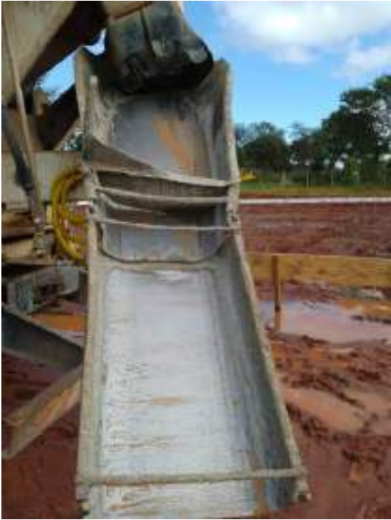
Lacre do caminhão de concreto
