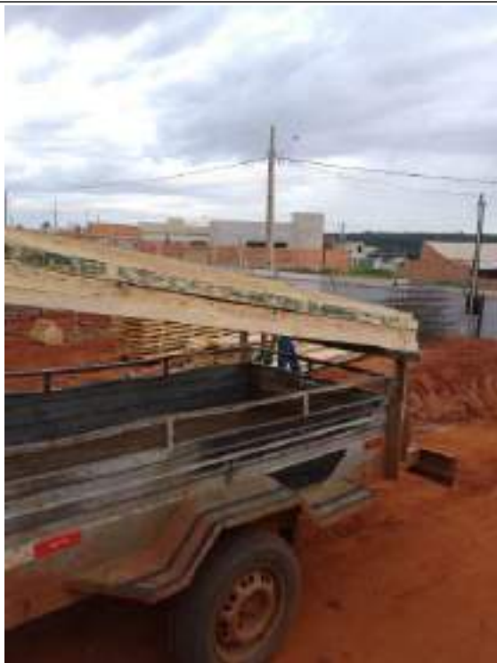
Chegada dos somente dos sarrafos
