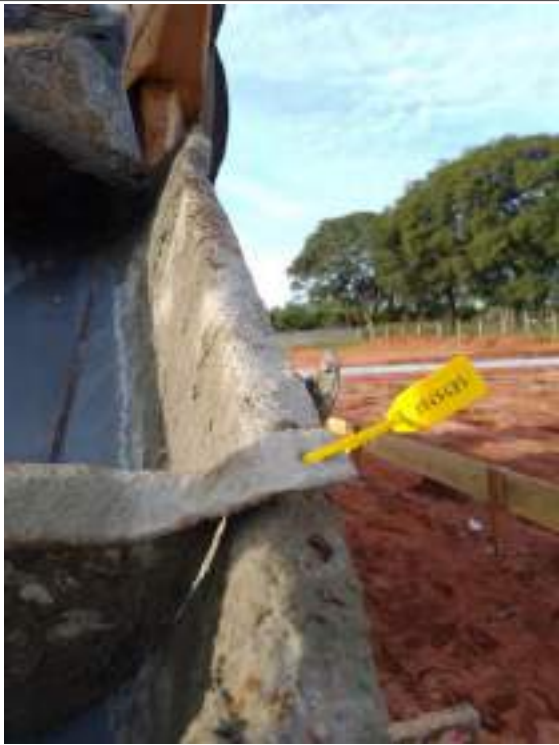
Lacre do caminhão de concreto
