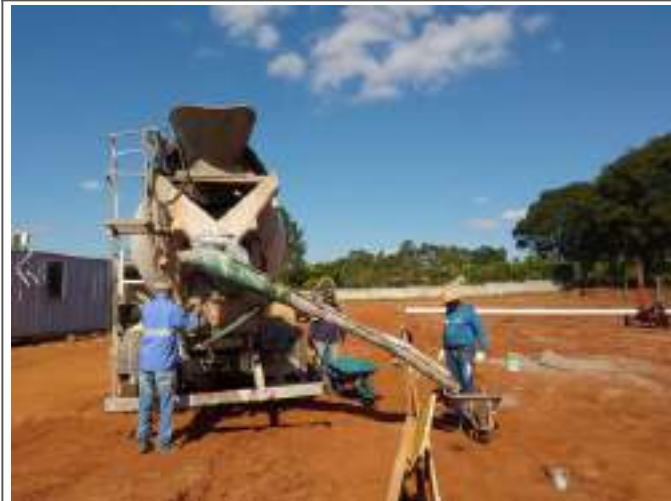
Descarregamento de Concreto
