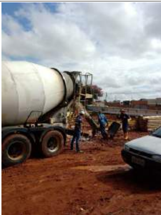
Caminhão de concreto
