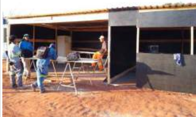
Canteiro de obras
