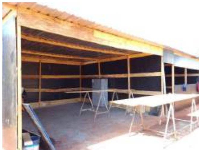
Canteiro de obras
