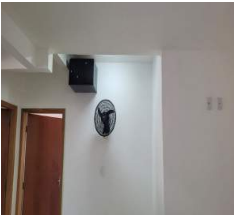
Imagem 11 – Pintura e instalações
