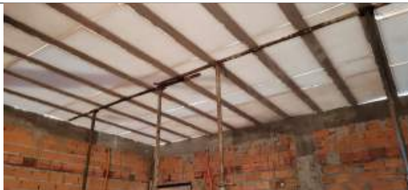
Imagem 02 – Instalação da laje
