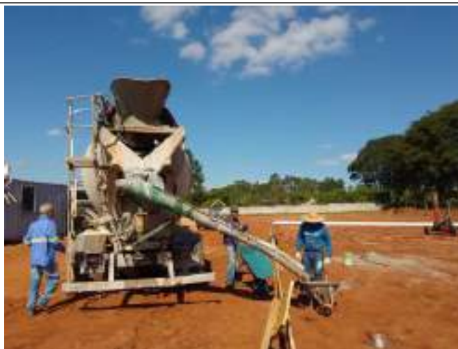
Descarregamento de Concreto
