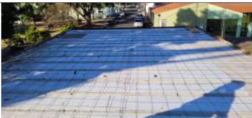
Imagem 05 – Instalação da laje
