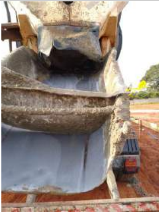
Lacre do caminhão de concreto
