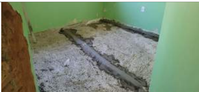
Imagem 09 – Concreto para nivelamento do piso
