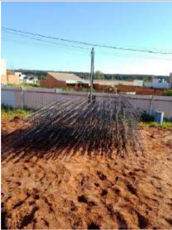
Arranque de pilar
