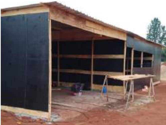
Canteiro de obras
