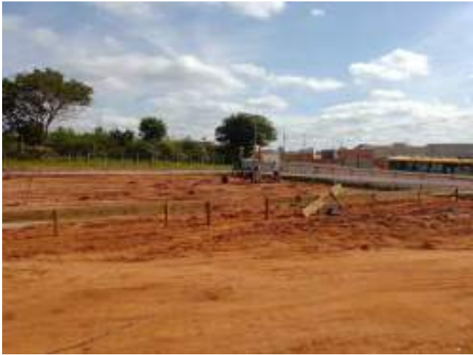
Inicio Estaca Franki com fuste apoiado.
