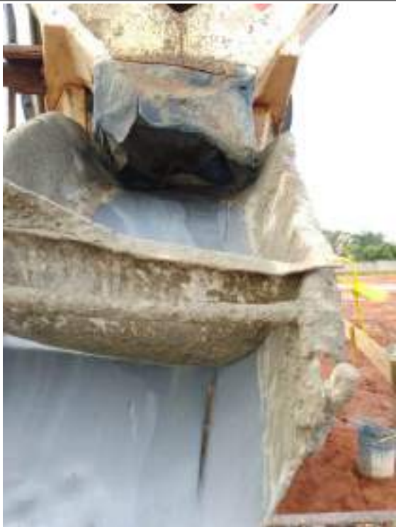
Lacre do caminhão de concreto
