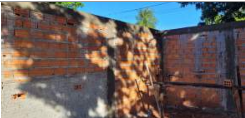
Imagem 02 – Construção do muro
