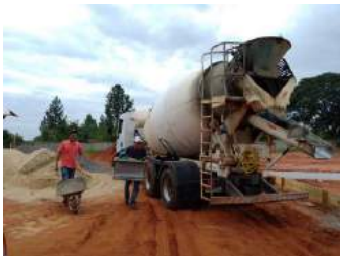
Descarregamento de concreto
