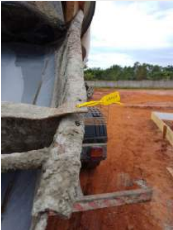
Lacre do caminhão de concreto- a tarde
