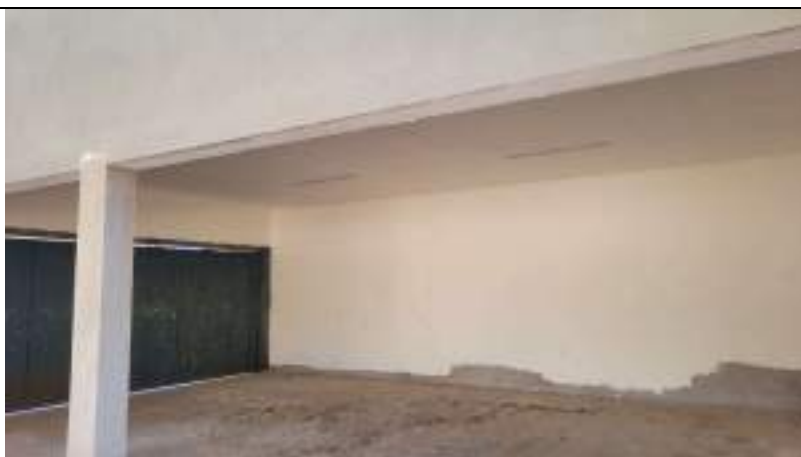
Imagem 06 – Pintura em teto e iluminação
