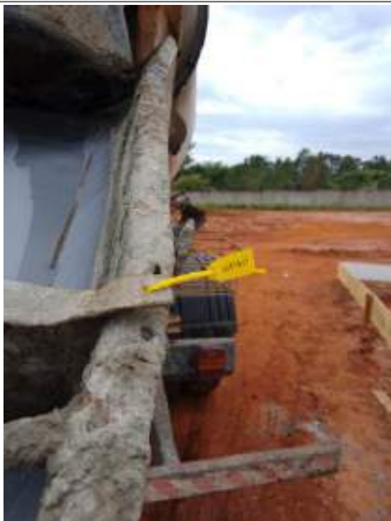
Lacre do caminhão de concreto- a tarde
