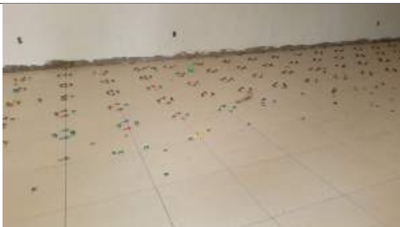
Imagem 07 – Porcelanato, massa corrida e instalação elétrica
