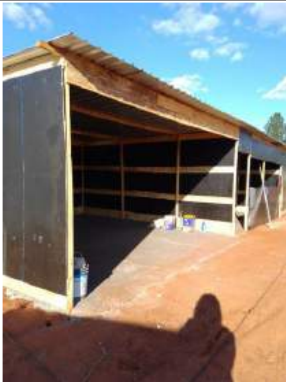
Canteiro de Obras
