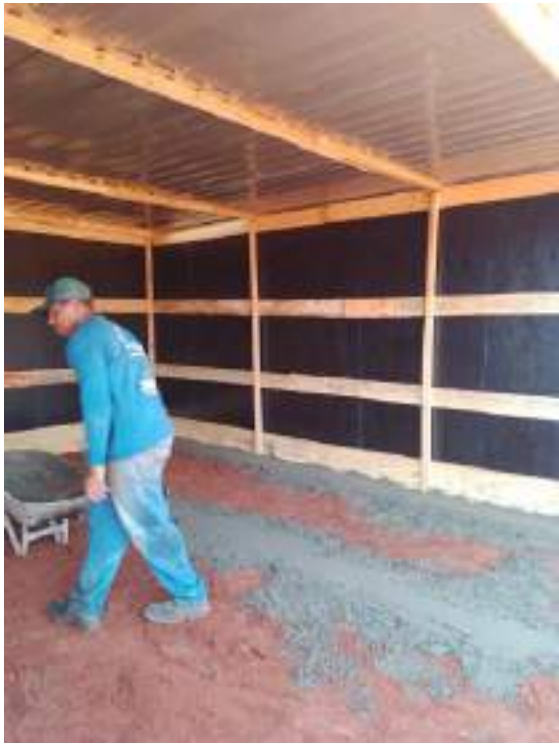
Canteiros de obras
