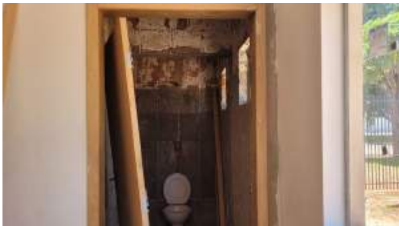
magem 07 – Banheiro, porta e batente
