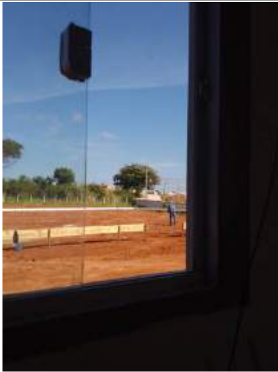
Inicio Estaca Franki com fuste apiolado.
