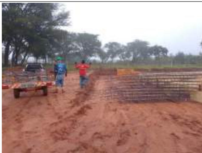
Segunda remessa aço baldrame
