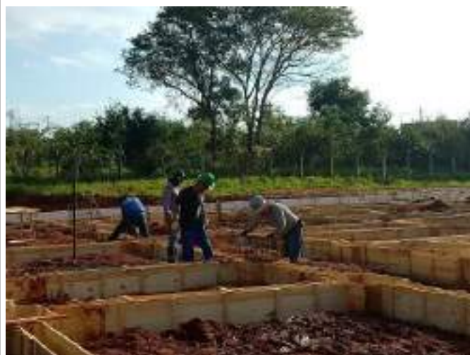
Montagem das armaduras horizontais das vigas baldrame
