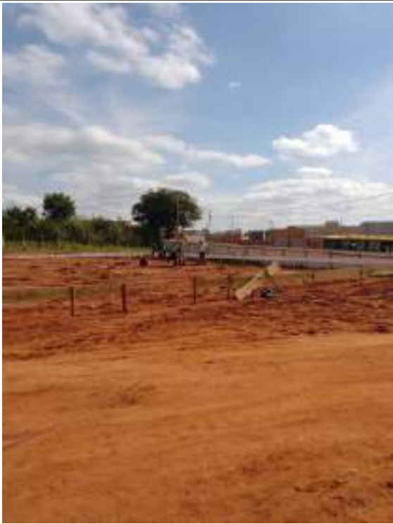
Inicio Estaca Franki com fuste apoiado.
