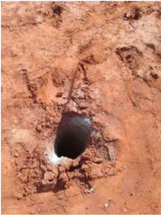
Inicio Estaca Franki com fuste apiolado.
