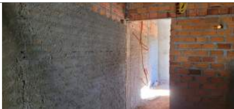
Imagem 04 – Chapisco e tubo PVC flexível
