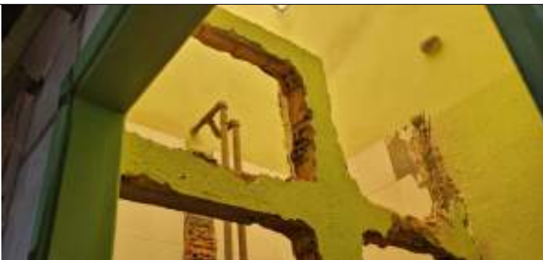
Imagem 10 – Demolição de alvenaria
