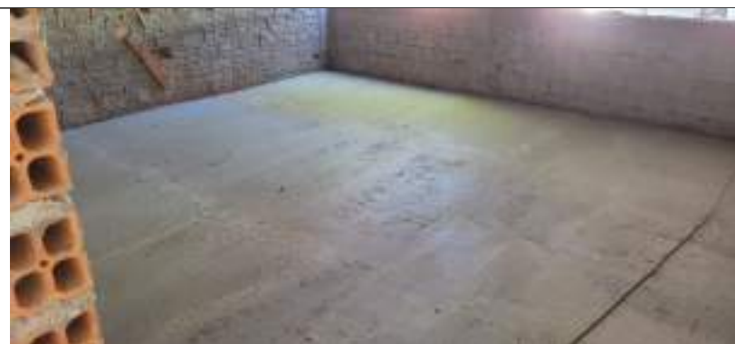
Imagem 07 – Contrapiso e chapisco
