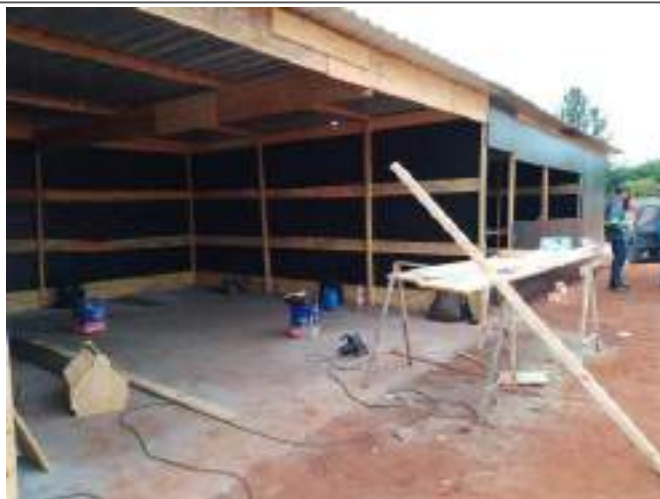
Canteiro de obras
