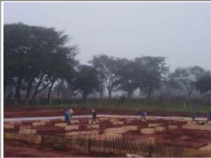
Desenvolvimento das formas para as vigas
