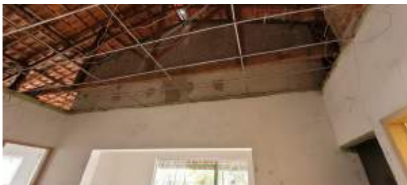
imagem 9 – Retirada do forro PVC
