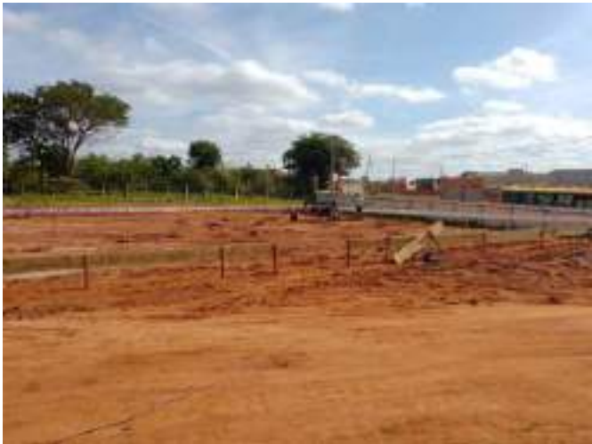
Inicio Estaca Franki com fuste apoiado.
