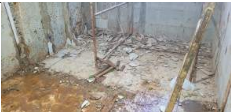
Imagem 09 – Demolição de revestimento cerâmico e alvenaria
