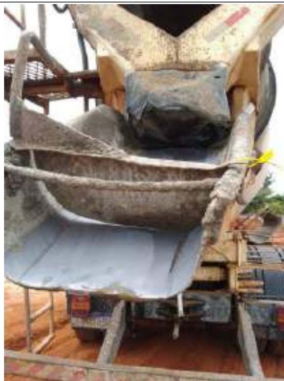
Lacre do caminhão de concreto- a tarde
