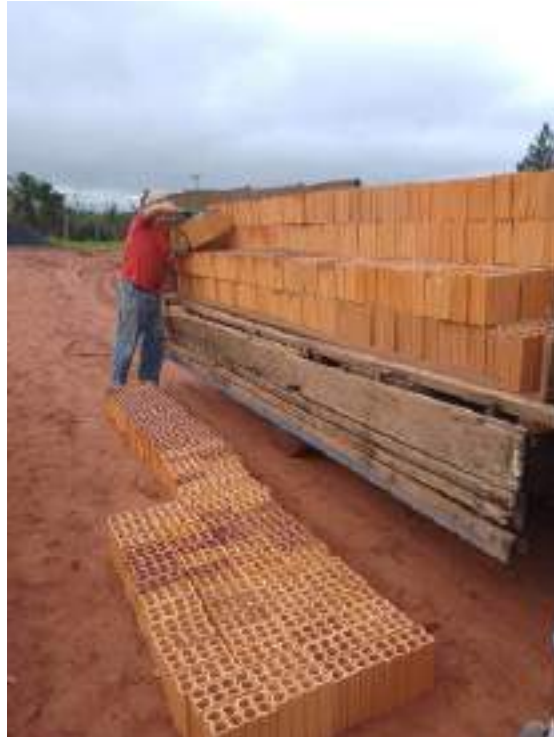
Chegada de mais 2 mil tijolos na parte da tarde
