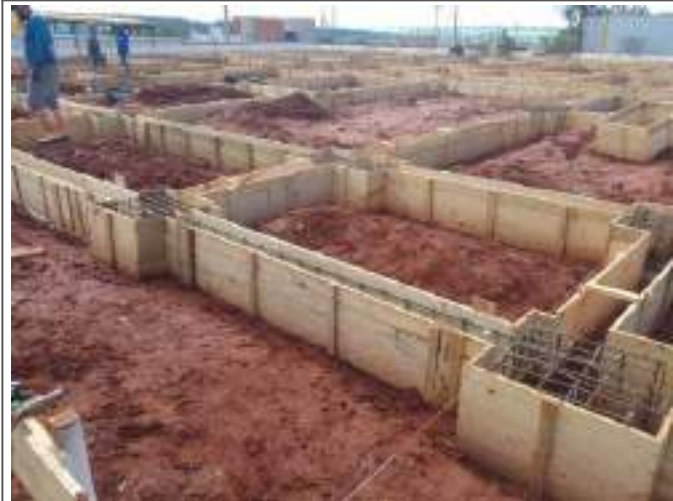
Montagem das armaduras horizontais das vigas baldrame
