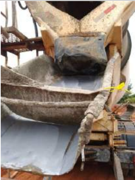
Lacre do caminhão de concreto- a tarde
