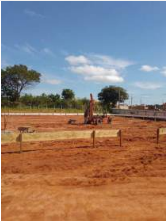
Inicio Estaca Franki com fuste apiolado.
