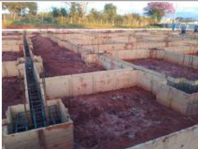
Interligação com as armações
