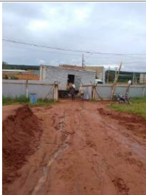
Descarregamento das 18 unidades de impermeabilizante
