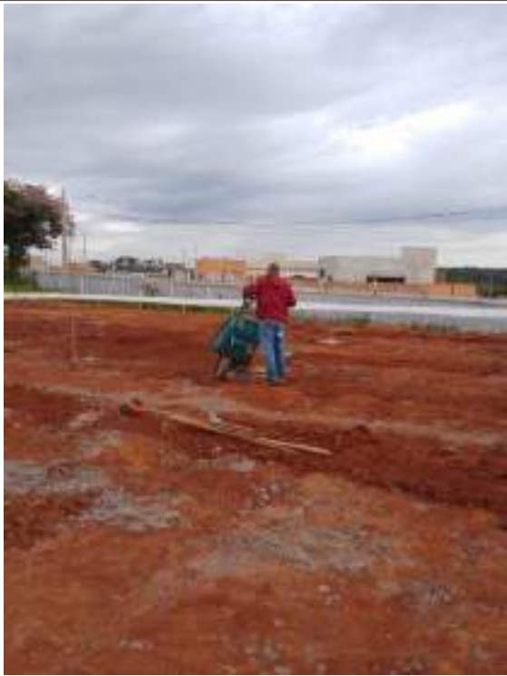
Enchimento das estacas
