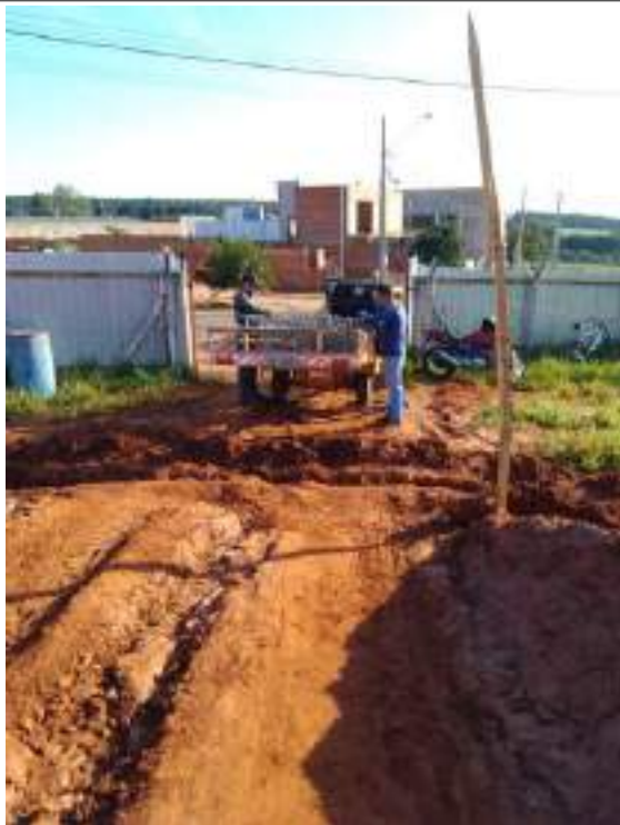
Arranque de pilar
