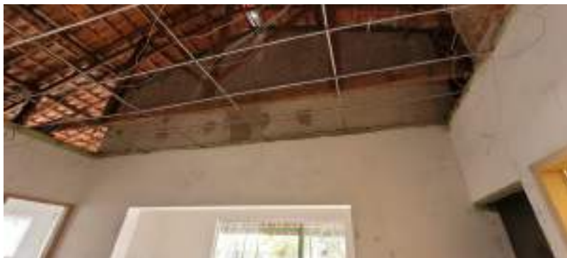
imagem 9 – Retirada do forro PVC
