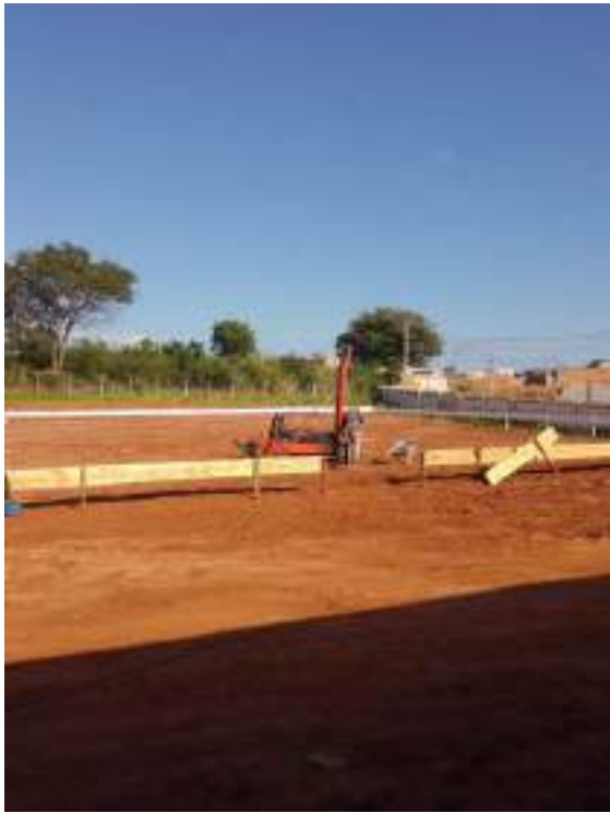
Inicio Estaca Franki com fuste apiolado.
