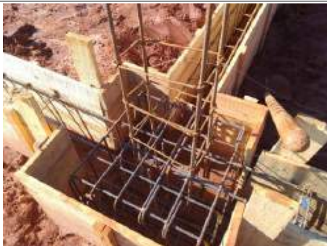
Interligação com as armações
