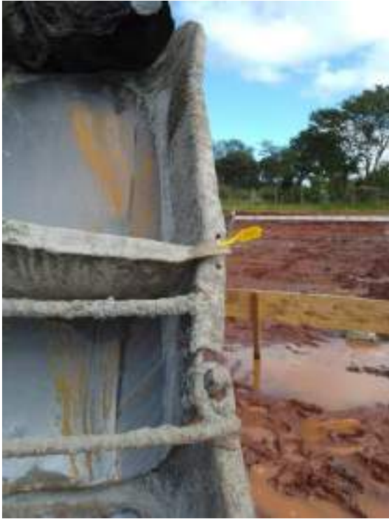
Lacre do caminhão de concreto
