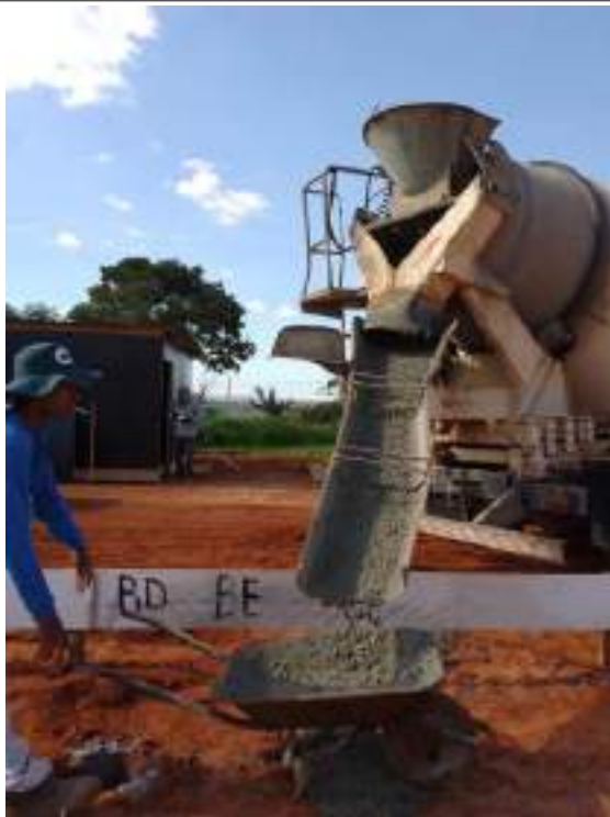
Descarregamento do concreto
