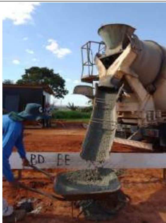
Descarregamento de Concreto
