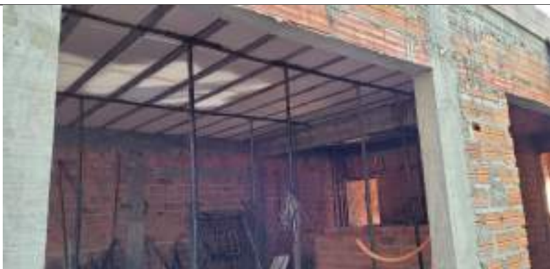
Imagem 03 – Instalação da laje
