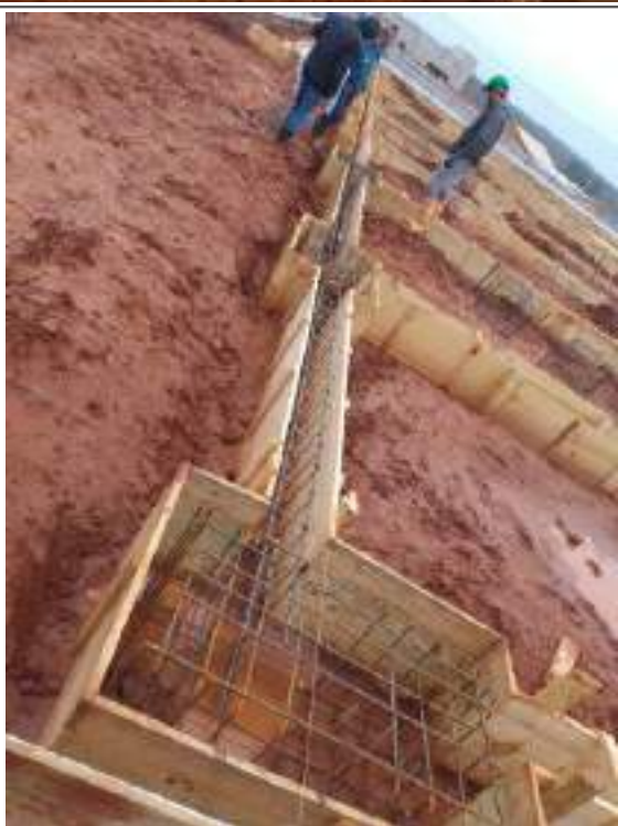
Montagem das armaduras horizontais das vigas baldrame
