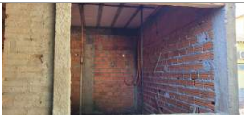
Imagem 04 – Alvenaria, laje e tubo flexível
