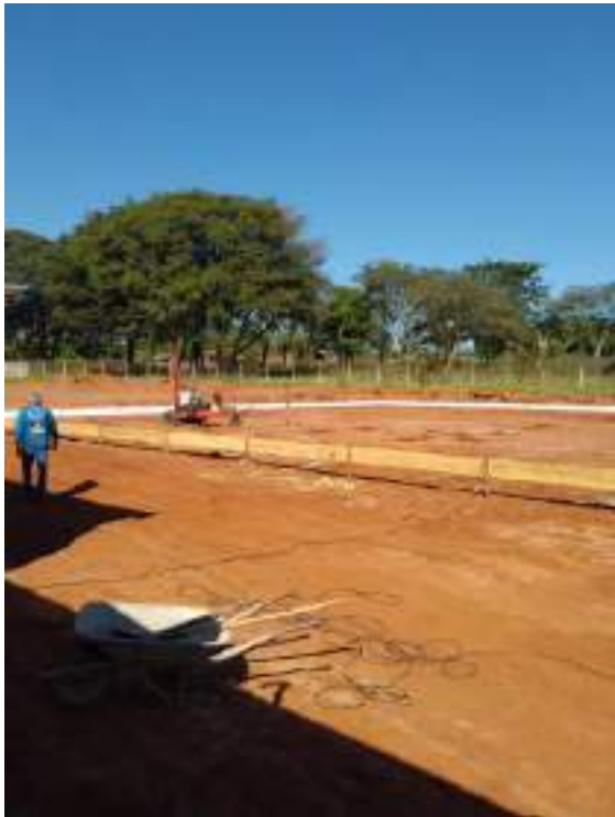
Andamento Estaca Franki com fuste apiolado.
