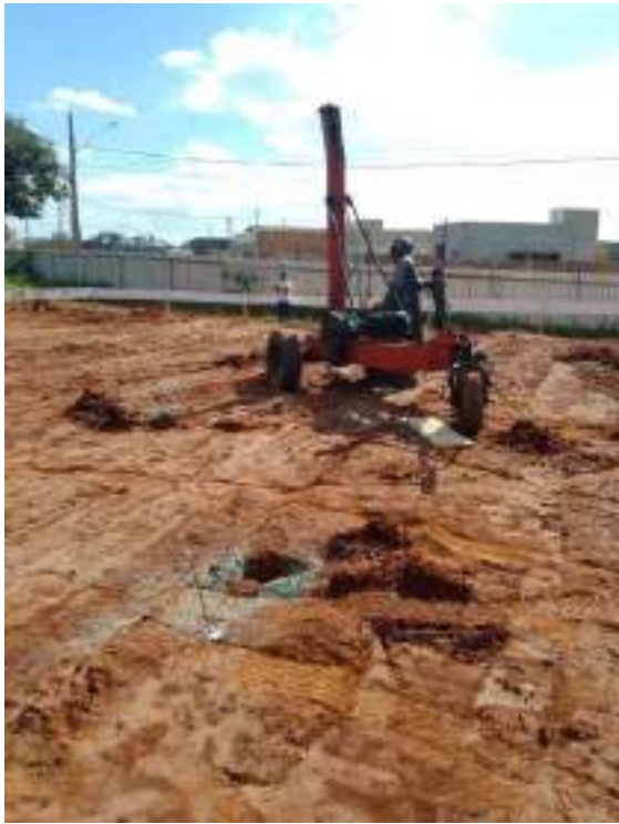
Inicio Estaca Franki com fuste apiolado.
