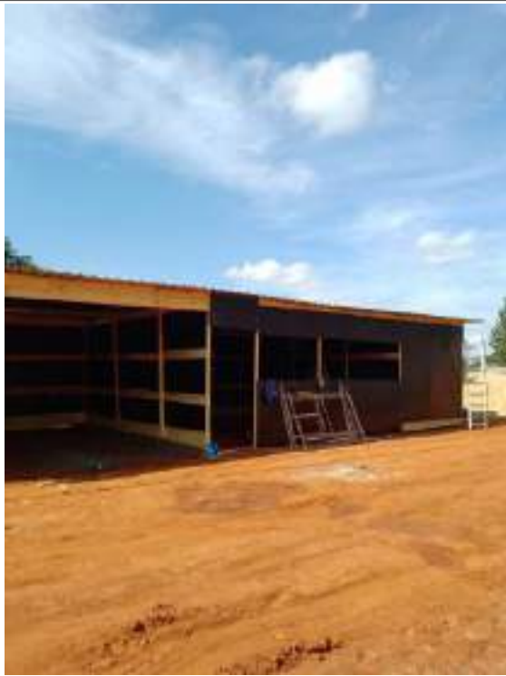
Canteiro de obras
