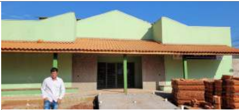
Imagem 10 – Telhado, ripa e testeira
