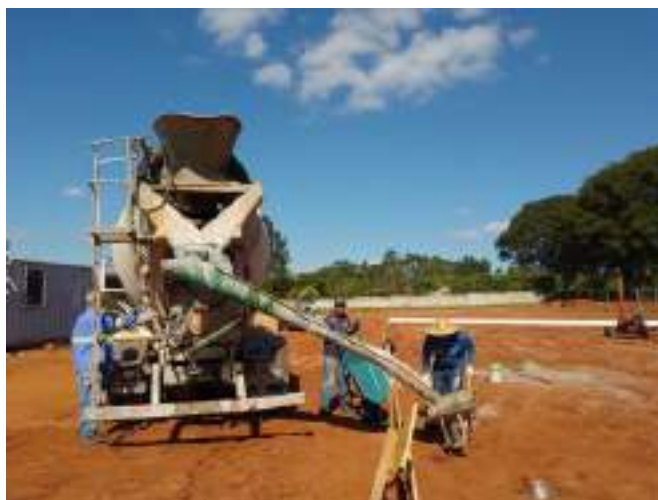
Descarregamento de Concreto
