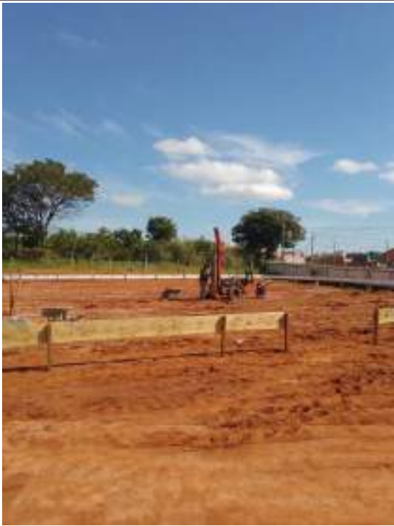
Inicio Estaca Franki com fuste apiolado.
