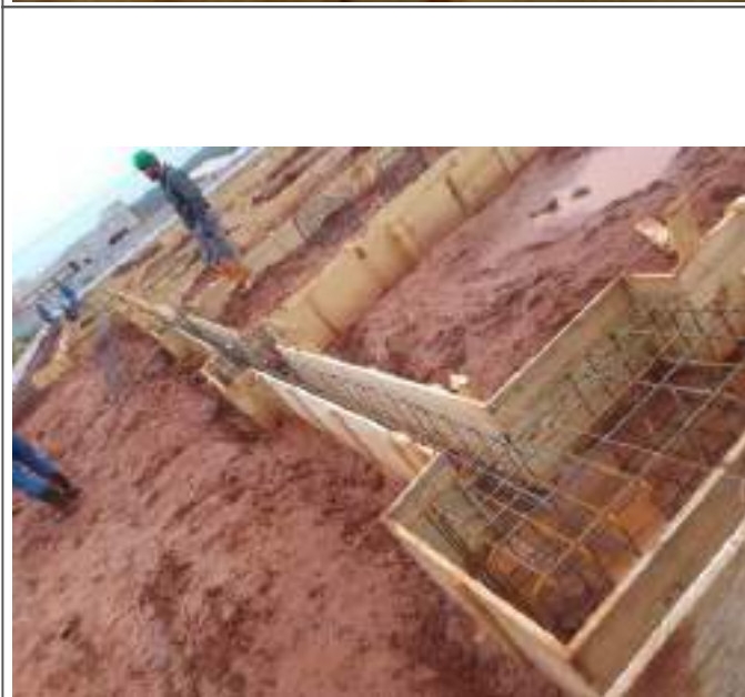
Montagem das armaduras horizontais das vigas baldrame
