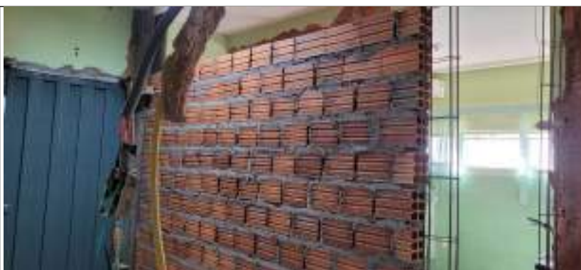
Imagem 05 – Construção de alvenaria
