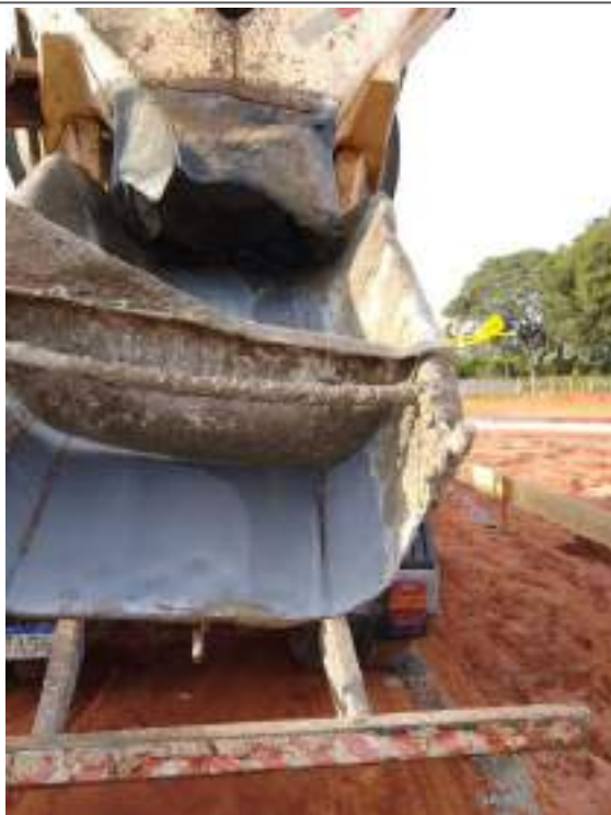
Lacre do caminhão de concreto
