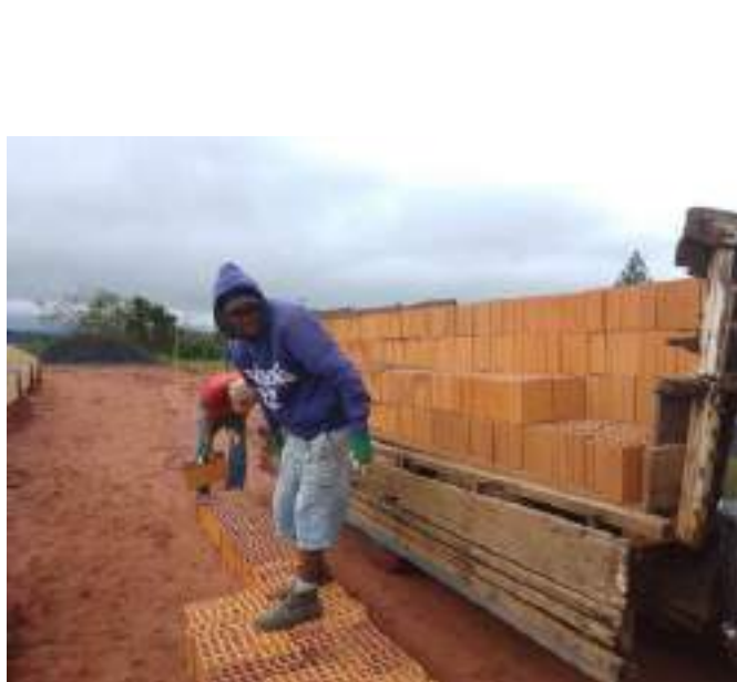
Chegada de mais 2 mil tijolos na parte da tarde
