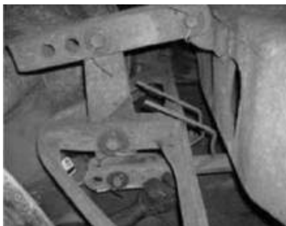
Figura 6 - Instalação antiqueda no pátio
