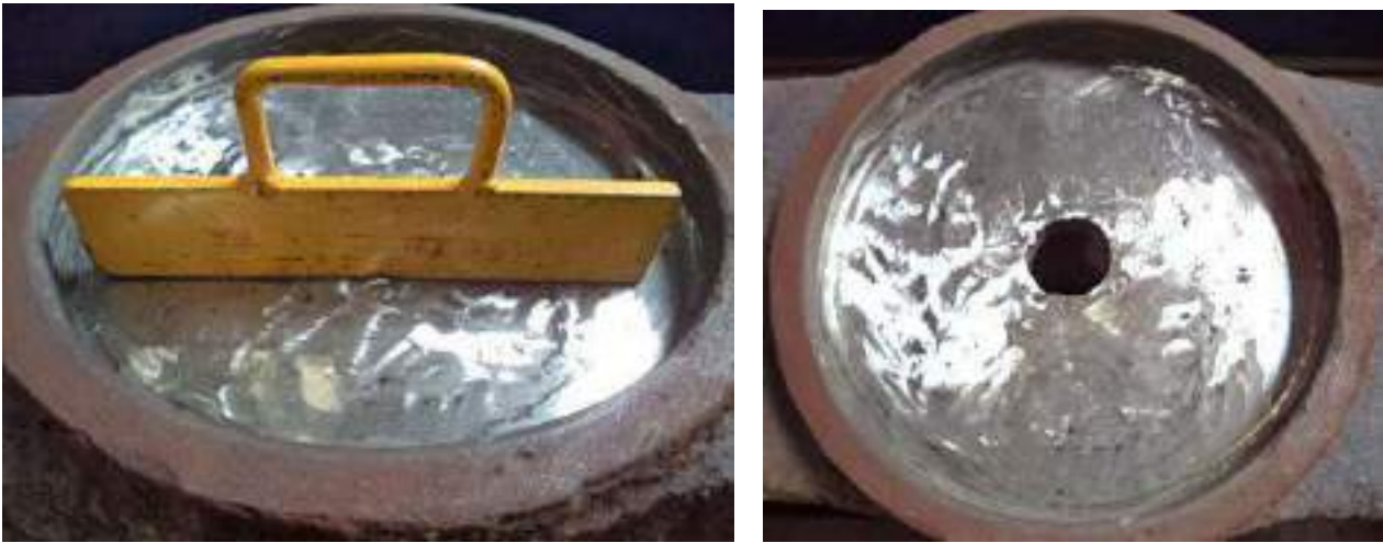
Figura 13: Correção dos desnivelamentos
