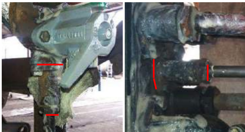
Figura 10 - Tubulação e ligações do retentor de alívio
