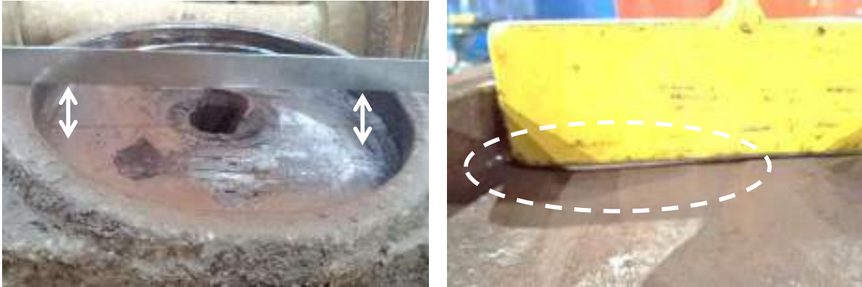
Figura 12: Verificação do prato pião inferior
