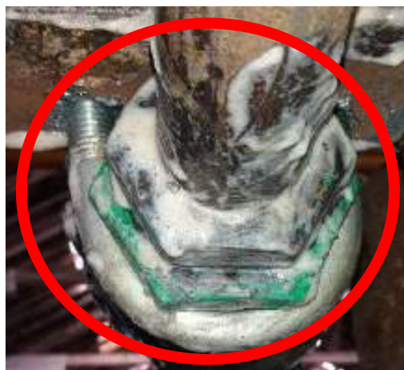
Figura 17 – Conexão com sabão
