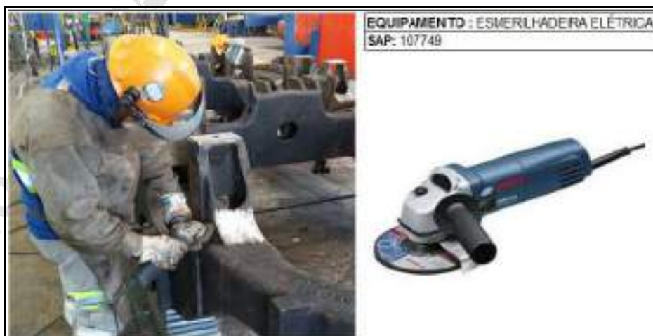
Figura 3 - Remoção da tinta utilizando esmerilhadeira elétrica.
