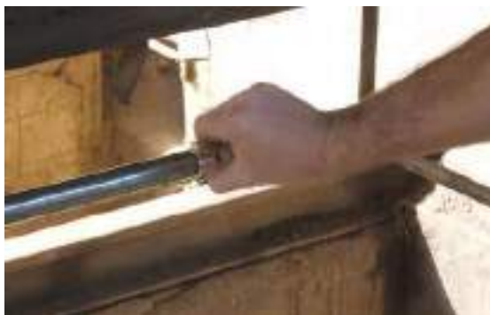
Figura 14- Marcação do tamanho da haste do ajustador
