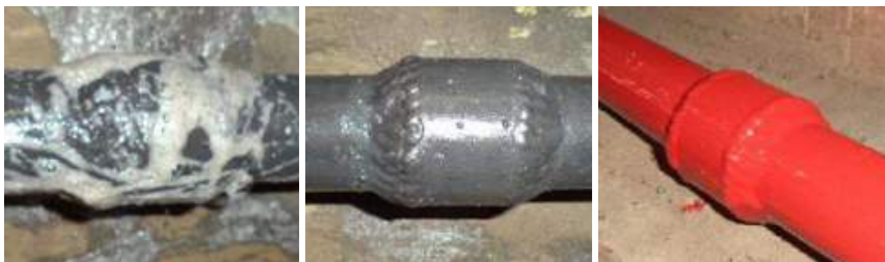
Figura 13 - Conexões soldadas do encanamento geral
