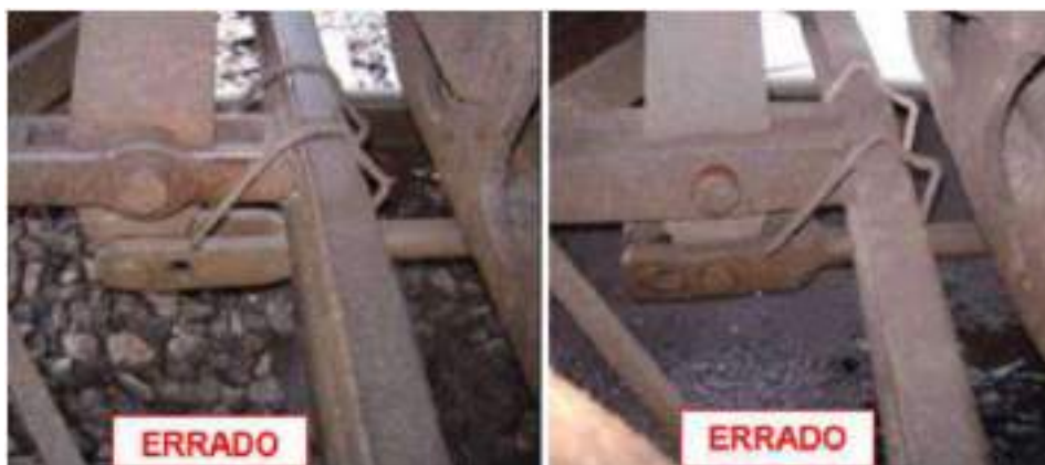
Figura 9 - Instalação incorreta, dispositivo deformado
