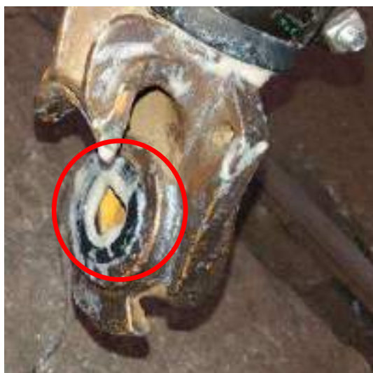
Figura 12 - Bocal da mangueira
