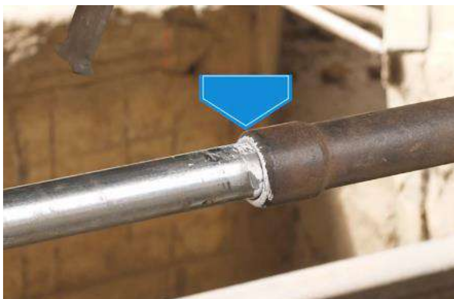
Figura 15- Verificação da atuação do ajustador
