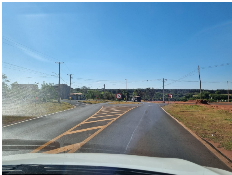
Imagem 02 – Trecho de acesso a loteamentos
