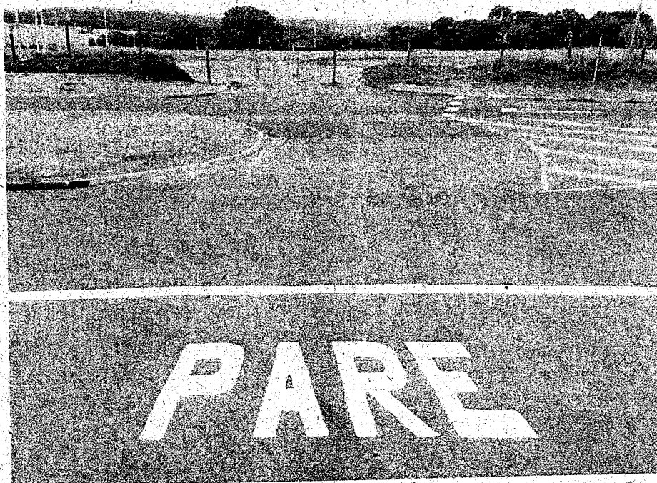
Foto 11 – Implantação de Trevo de Acesso - Guias/Sarjetas, Pavimentação e Sinalização.
