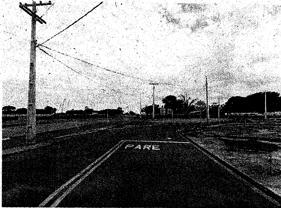
Foto 07 – Rede de Energia Elétrica e Sinalização Horizontal/Vertical.
