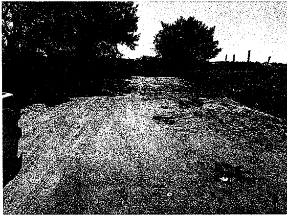
Trecho A1 – Início do trecho
