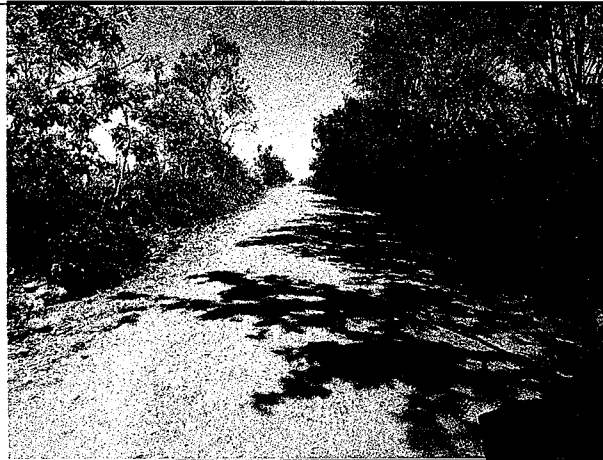
Trecho A1 – Barranco e vegetação lateral
