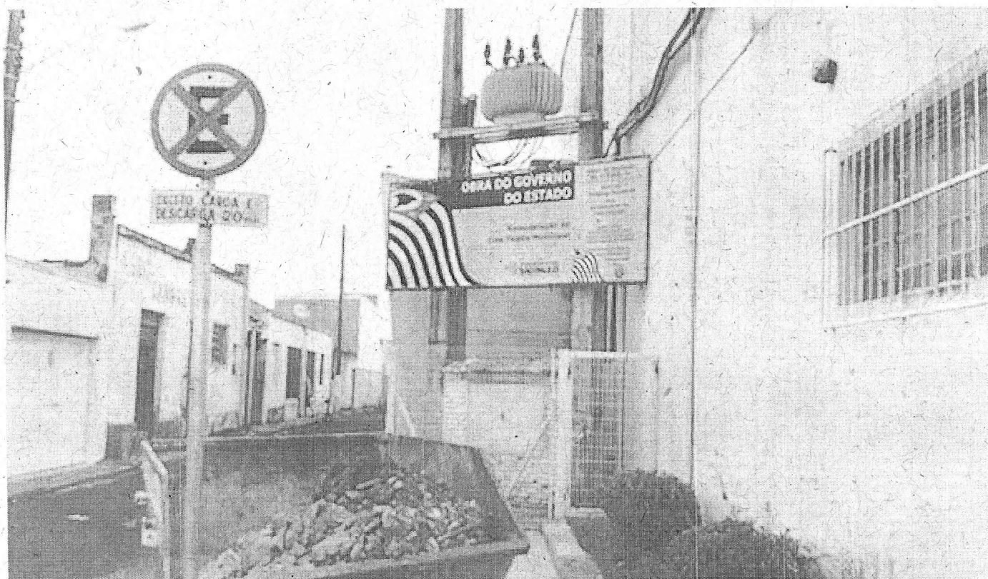
Obras seguem firme na reformulação total do Cine Teatro Municipal "Lucila Nascimento" de Paraguaçu Paulista
