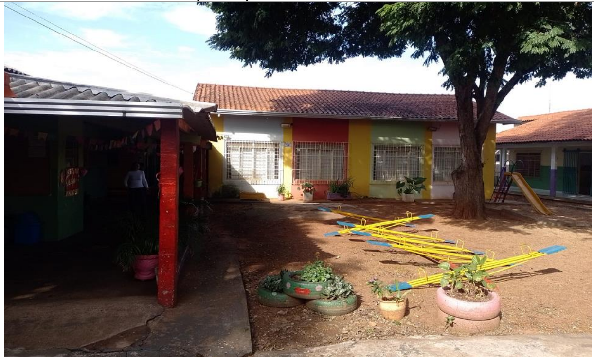
F02- Vista da Entrada da Creche
